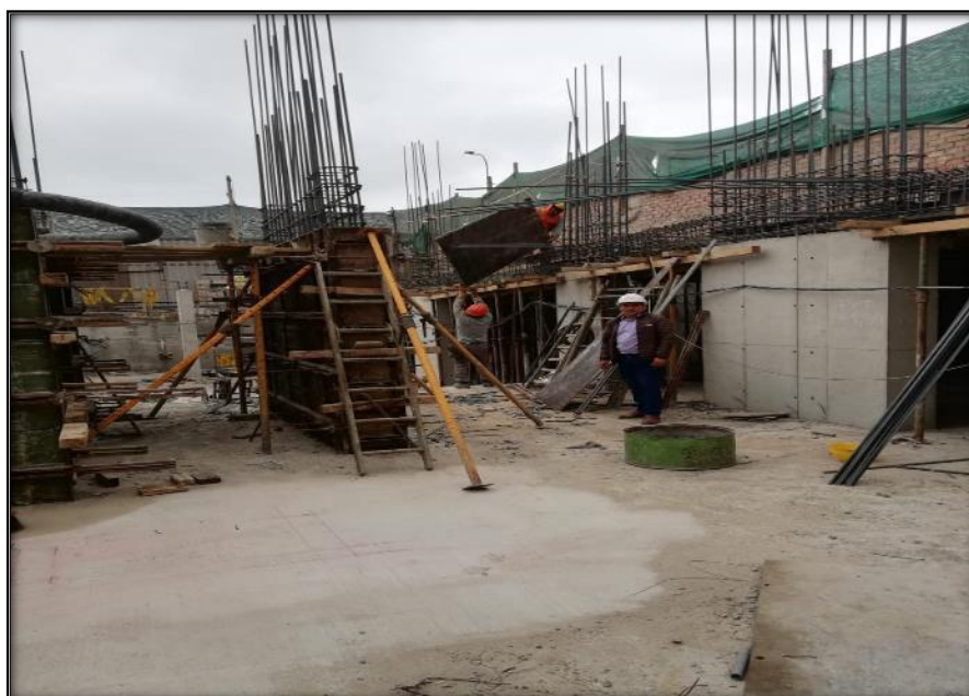
Figura N° 60 Traslado de encofrado para viga.
