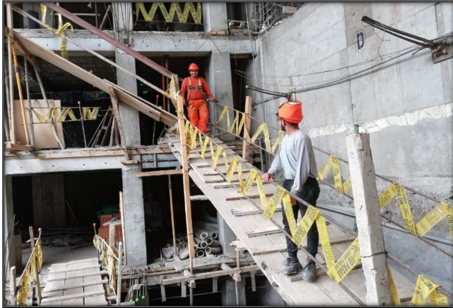
Figura N° 61 Los viajes de trabajadores dentro de la obra
