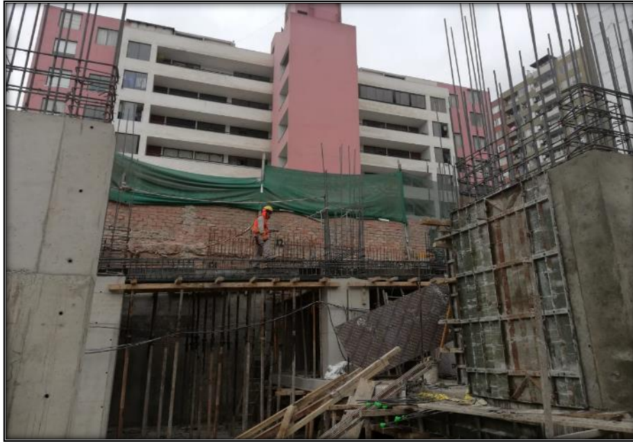
Figura N° 55 Verificando los fierros de compresión y tracción de la viga
