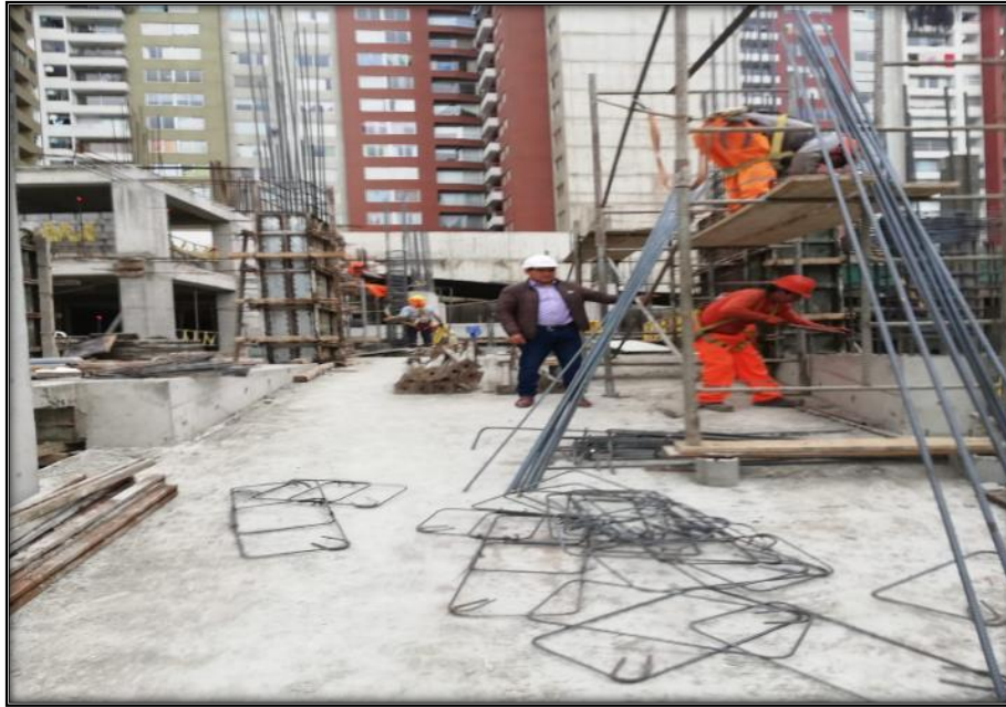
Figura N° 57 Verificando la colocación y cantidad de estribo en la placa.
