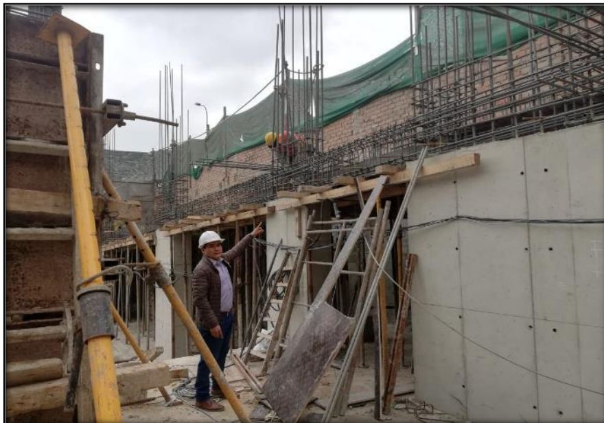
Figura N° 54 Colocando los estribos en la viga
