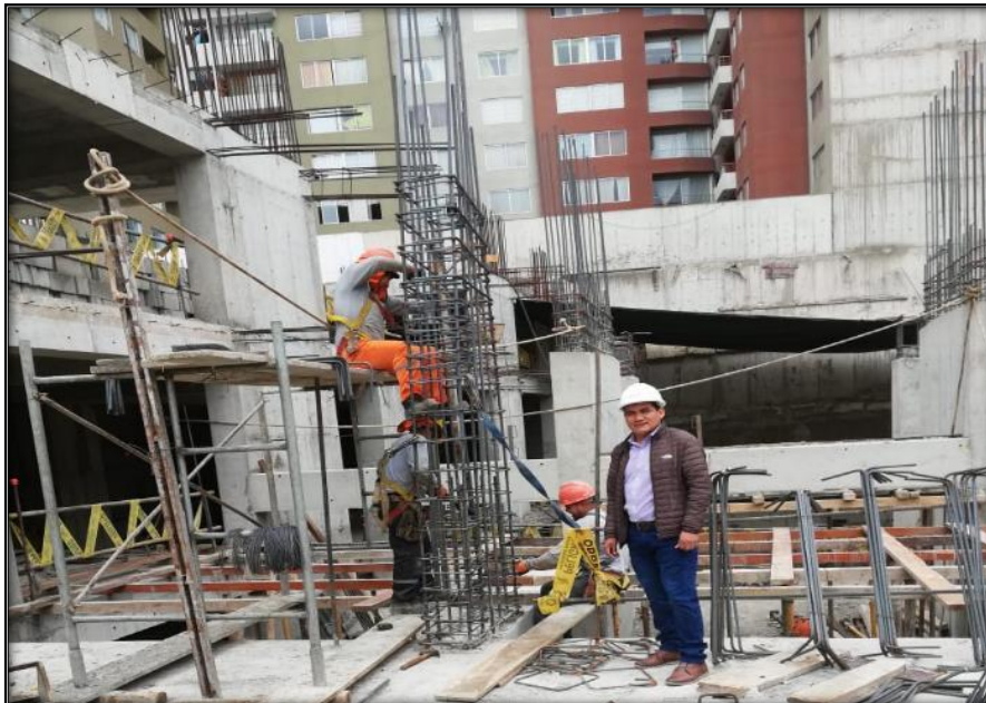
Figura N° 58 Colocando estribo en placa adyacente.
