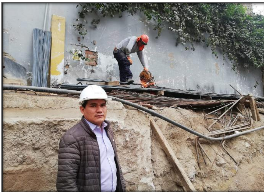
Figura N° 59 Cortado de fierro para placas.
