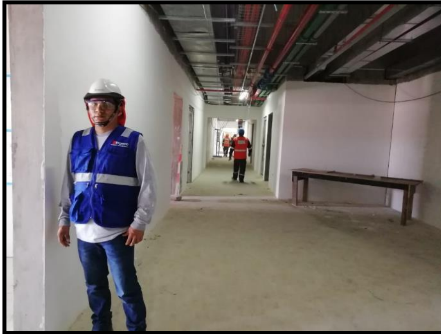
Figura N° 67 Inspección de los trabajos según la planificación maestra de toda la obra.
