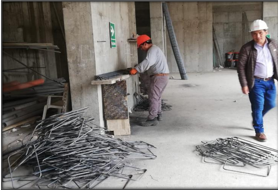
Figura N° 53 Doblado de fierro para los estribos de la viga.
