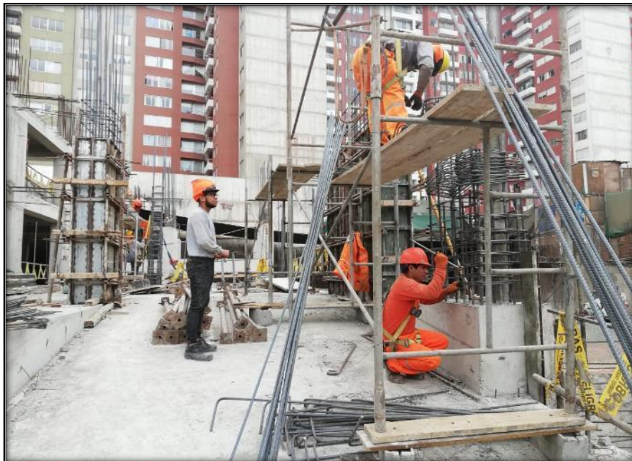
Figura N° 56 Colocación de los estribos en la placa.
