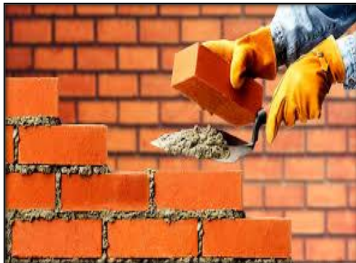
Figura N° 9. Asentado de ladrillo.
