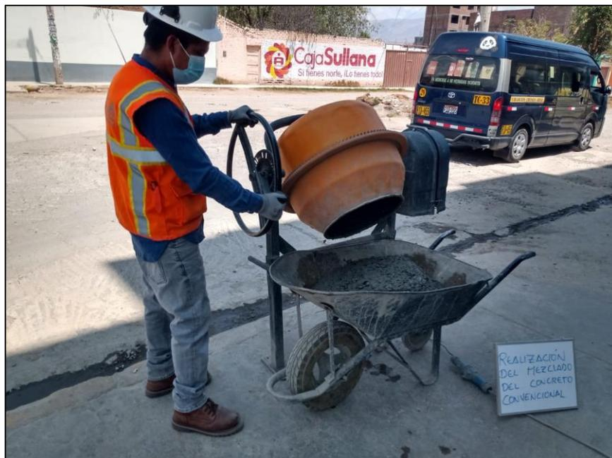
*Figura 6. Vaciado del concreto para colocación en probetas y vigas prismáticas*
