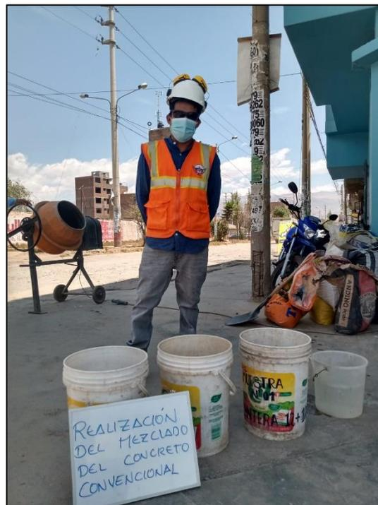
*Figura 4.* Materiales para la mezcla de concreto (cemento, arena, piedra chancada y agua)
