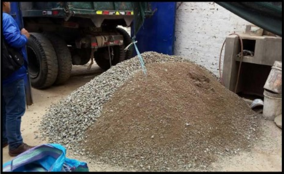
Imagen 1. Traslado y colocación de agregados
