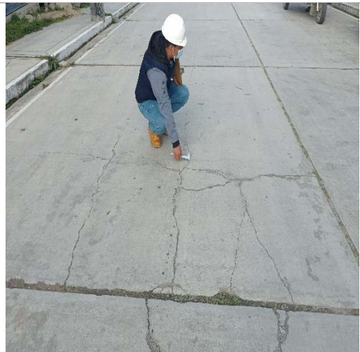
Fotografía 6 – Daño del sello de junta
