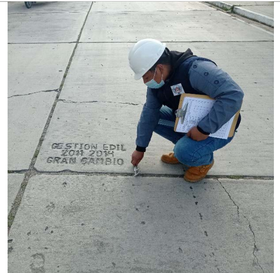
Fotografía 24 – grieta lineal y escala en paños
