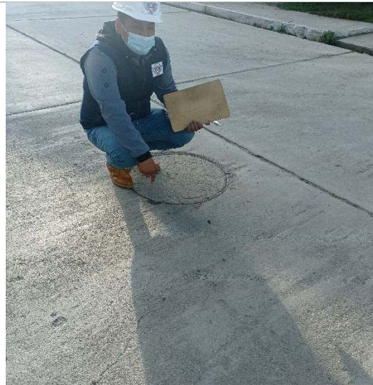
Fotografía 23 – grieta lineal con daño alto (H)
