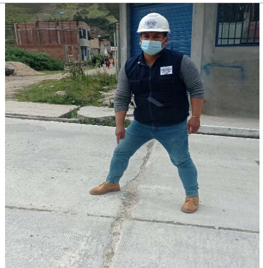
Fotografía 12 – Descascaramiento de junta
