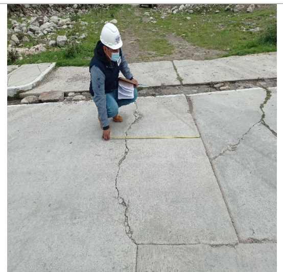
Fotografía 24 – grieta lineal y escala en paños
