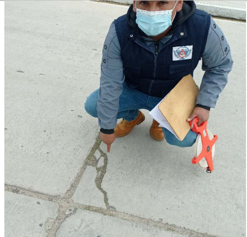
Fotografía 4 – Losa dividida
