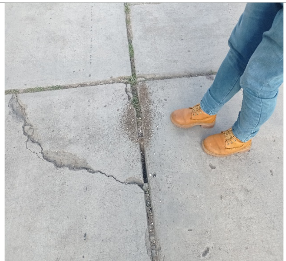
Fotografía 6 – Daño del sello de junta
