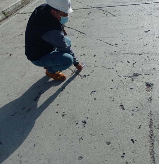
Fotografía 12 – Descascaramiento de junta
