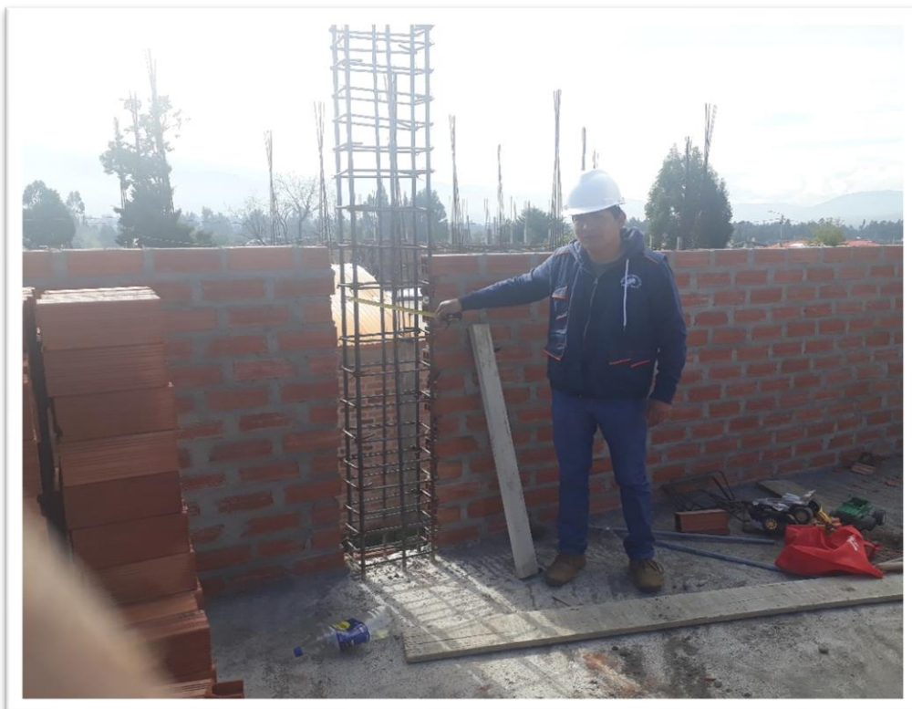
Vista 06.- En la vista se observa la construcción del segundo nivel.
