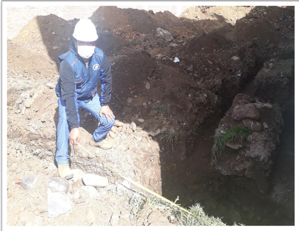
Vista 01.- En la vista se verifica el inicio de la Excavaciones para las zapatas.
