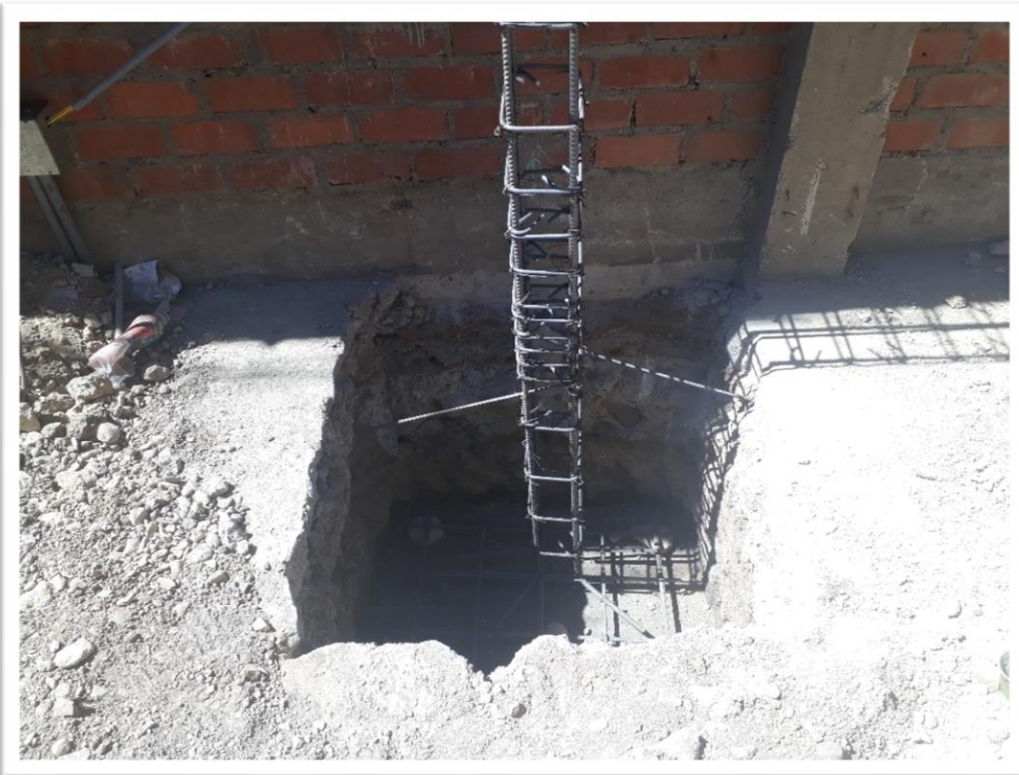
Vista 03.- En la vista se observa la colocación del castillo de columna en la zapata.
