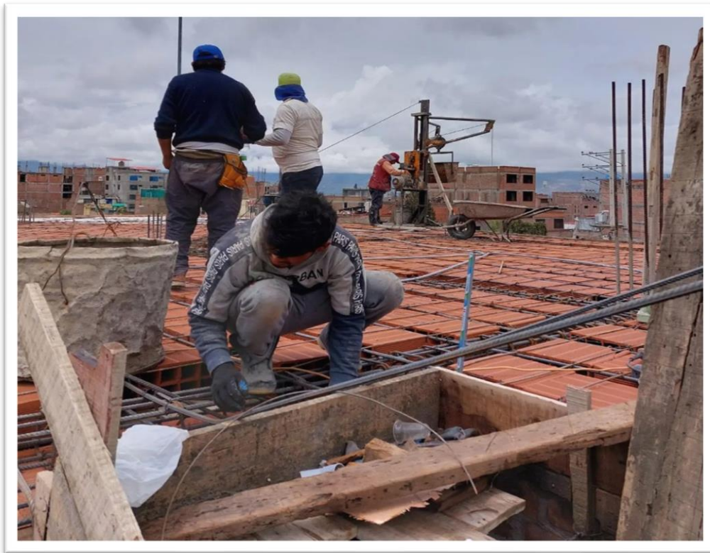
Vista 07.- En la vista se observa la construcción del segundo nivel.
