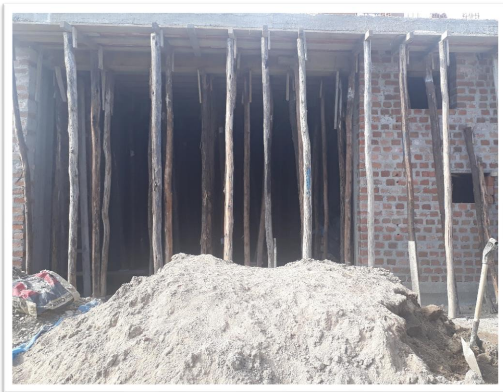
Vista 05.- En la vista se observa la Primera planta de la vivienda.
