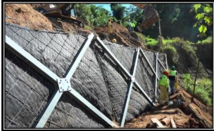
*Figura N° 21 –sistema ErdoX en construcción. Tomada de “Betonform LA”, por Urteaga, 2017, p. 29.*
