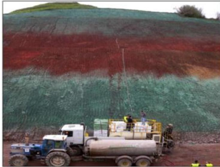
*Fotografía N° 01* – Aplicación de semillas mediante la hidrosiembra. Tomada de “Tecnología de la Hidrosiembra – Natur Group”, por Copello, 2015, p. 62.
