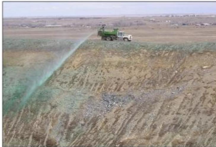
*Fotografía N° 02* – “Aplicación de las semillas sin acceder al talud. Tomada de Tecnología de la Hidrosiembra – Natur Group”, por Copello, 2015, p. 63.
