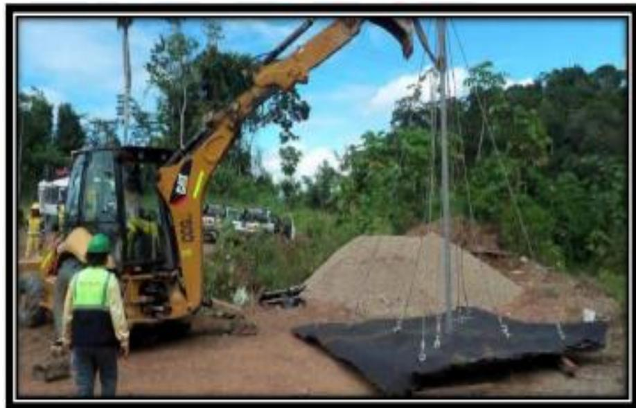
*Figura N° 19 – “Armado de elementos ErdoX. Tomada de “Betonform LA”, por Urteaga, 2017, p. 25.*
