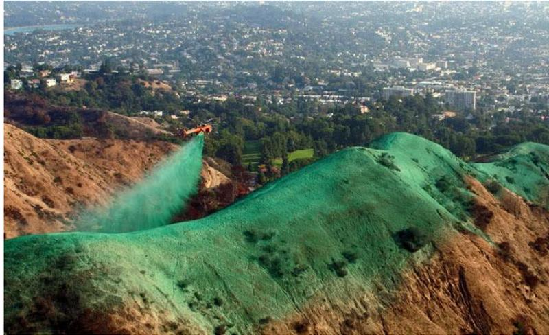
*Fotografía N° 03 – “Remediación mediante la técnica de la hidrosiembra. Tomada de Tecnología de la Hidrosiembra – Natur Group”, por Copello, 2015, p. 64.*
