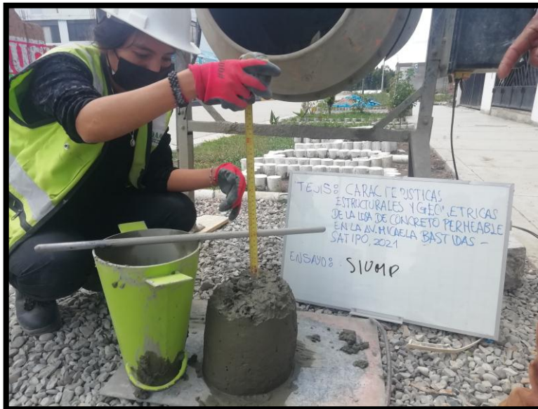
Figura 26 Asentamiento del concreto convencional
