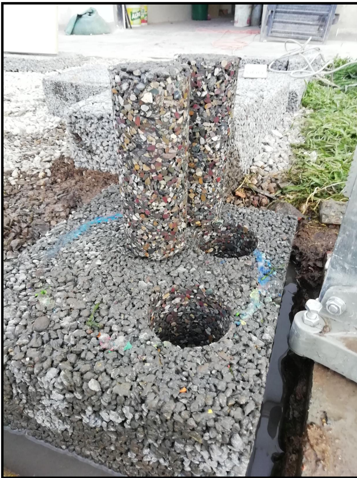
Figura 47 Extracción de diamantina losa de concreto permeable
