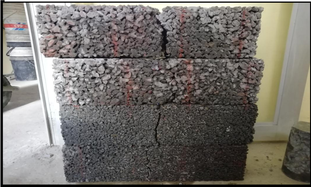
Figura 39 Rotura de la viga al tercio medio
