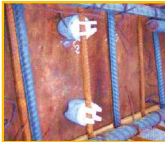
Figura 8: Dados para asegurar el recubrimiento
