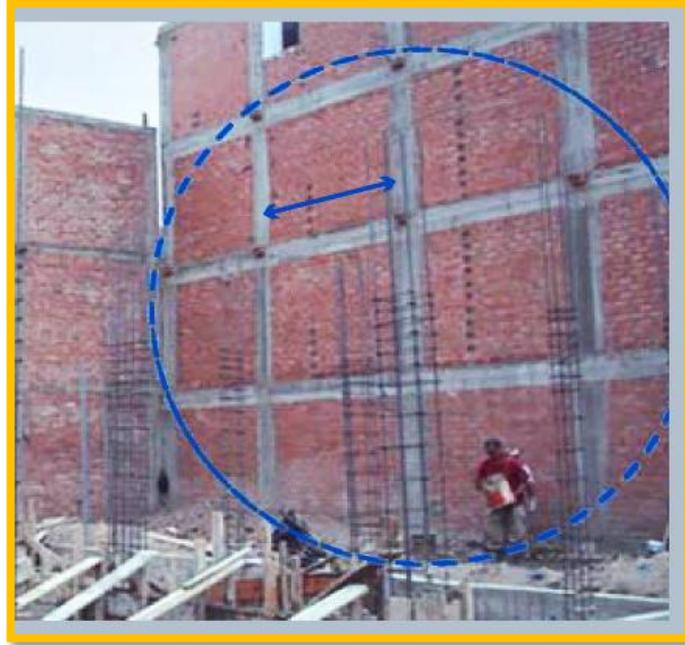
Figura 12: Albañilería confinada
