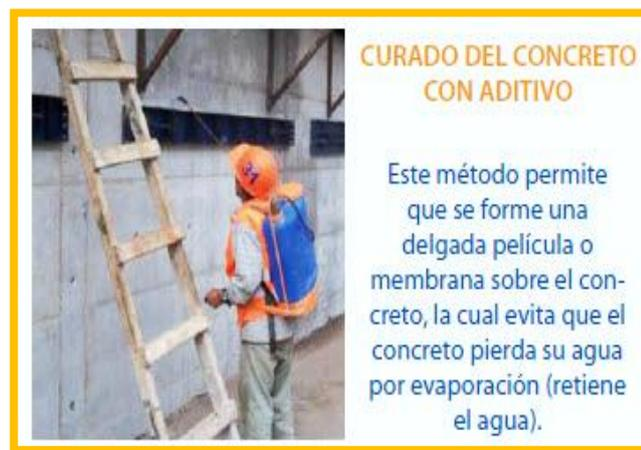
Figura 10: Curado del concreto con aditivo
