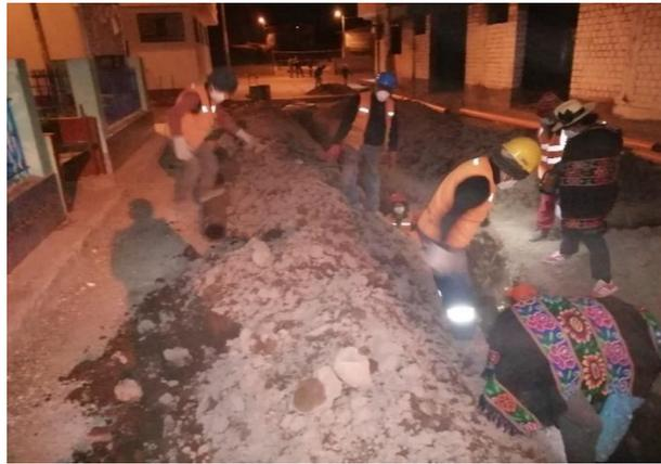
Imagen 46: fuente propia, excavación manual
