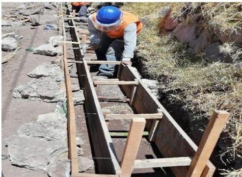
Imagen 32: fuente propia, encofrado de canales
