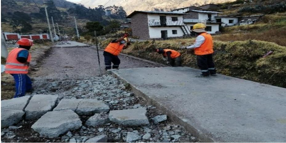
Imagen 24: fuente propia, demolición manual
