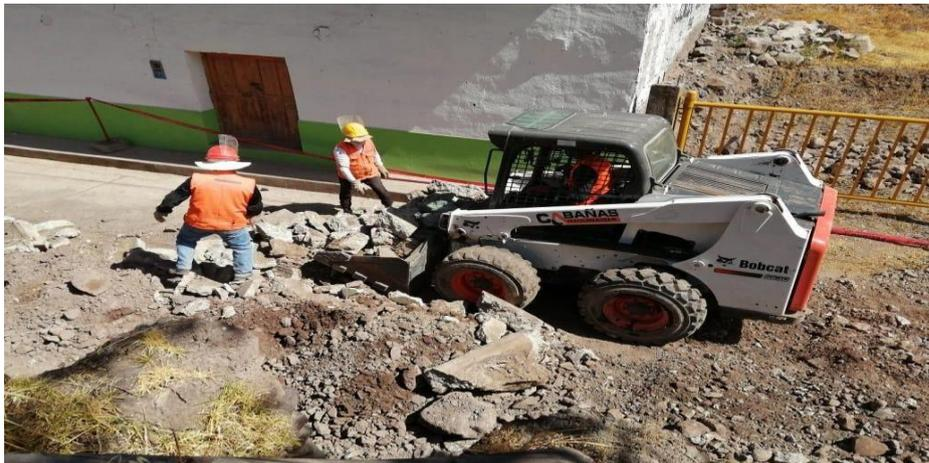
Imagen 25: fuente propia, demolición con maquinaria
