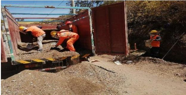
Imagen 40: fuente propia, descarga manual de material
