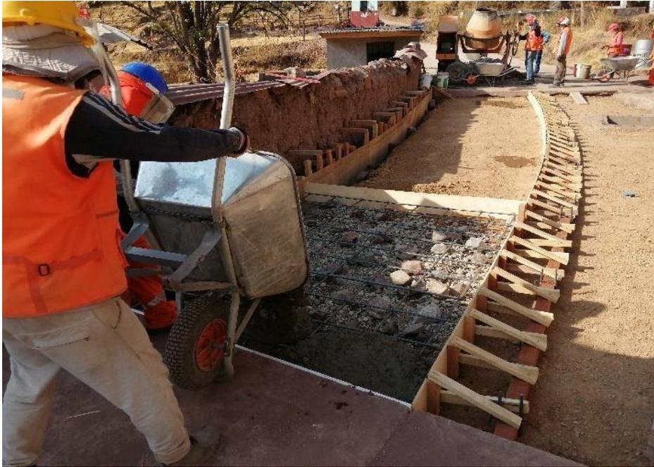
Imagen 51: fuente propia, vaciado manual de concreto en pavimento rígido
