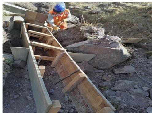
Imagen 35: fuente propia, encofrado de canales
