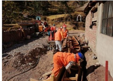
Imagen 31: fuente propia, encofrado de canales
