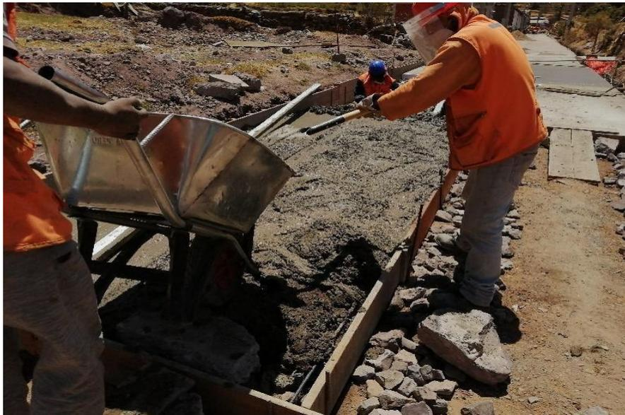
Imagen 54: fuente propia, vaciado manual de concreto en pavimento rígido
