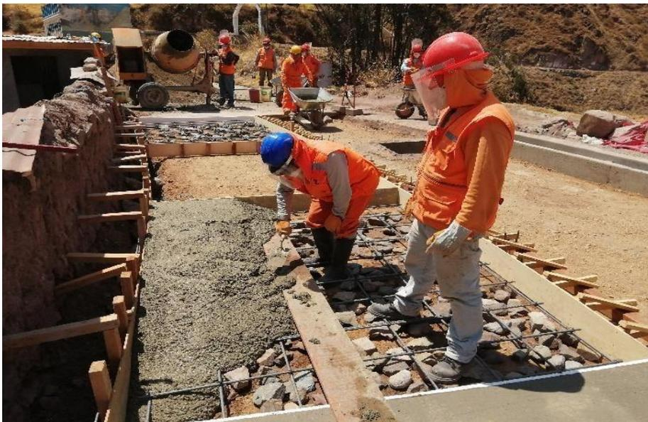
Imagen 52: fuente propia, vaciado manual de concreto en pavimento rígido
