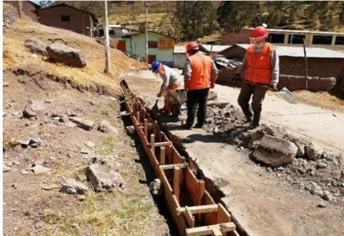
Imagen 30: fuente propia, encofrado de canales
