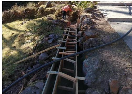
Imagen 33: fuente propia, encofrado de canales
