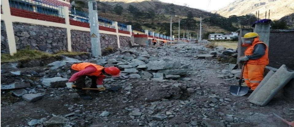
Imagen 21, fuente propia: Se realizó la demolición de forma manual.
