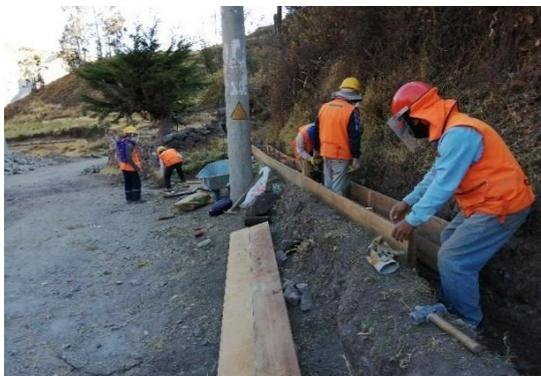
Imagen 34: fuente propia, encofrado de canales
