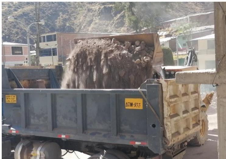
Imagen 50: fuente propia, eliminación de material con volquete, para la eliminación del material de desmonte, se utilizó maquinaria.
