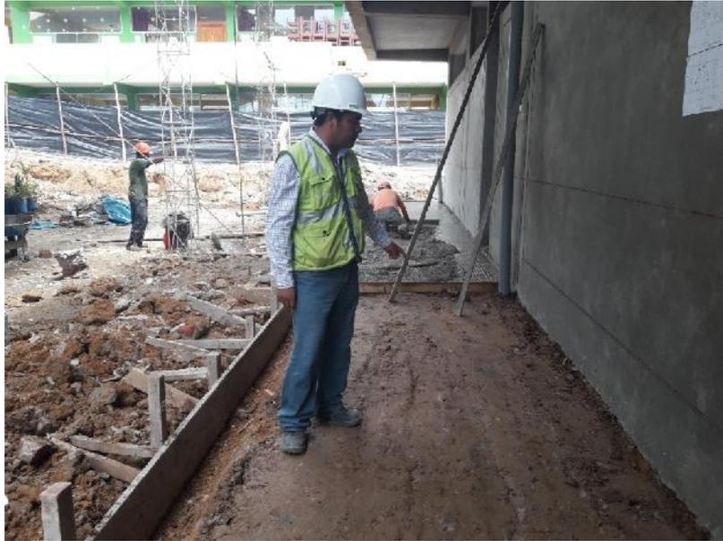
En la fotografía se muestra la verificación de los trabajos de conformado de base granular, perfilado y compactado para la conformación de veredas
