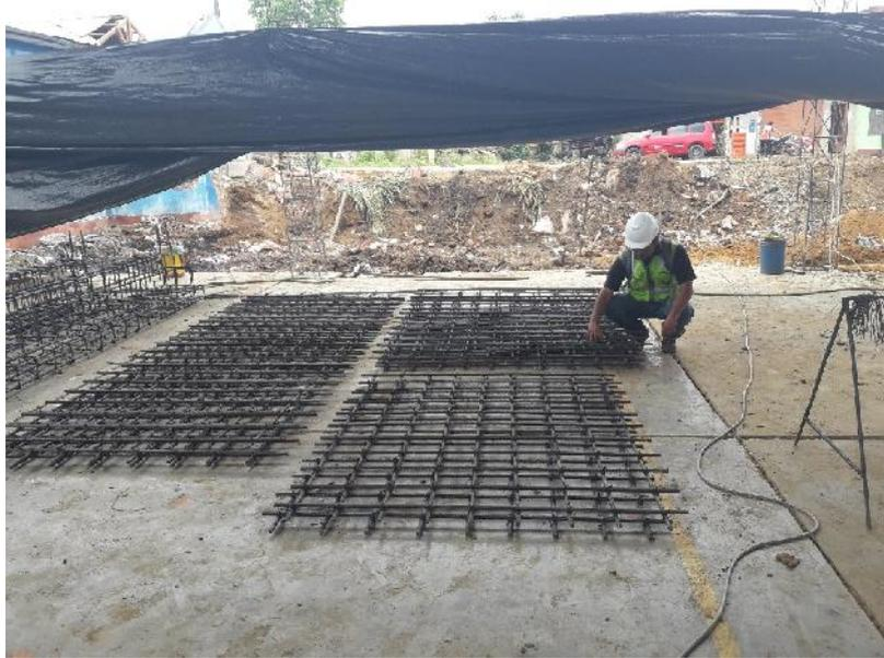
En la fotografía se muestra el trabajo de verificación de los trabajos de fierrea en este caso se verifica el diámetro de acero, separaciones y correcto amarre de las parrillas para las zapatas rectangulares
