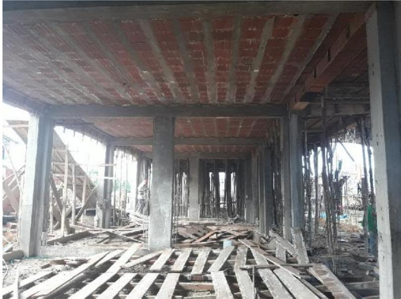
En la fotografía se muestra El proceso de desencofrado de losa aligerada, como se puede visualizar no hay presencia de cangrejas y las viguetas mantienen su ancho a lo largo de la losa
