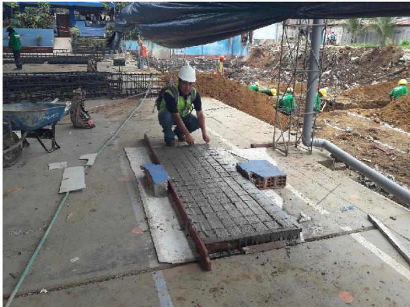
Para garantizar los recubrimientos del acero de los elementos estructurales y además para servir de apoyo en las parrillas de las zapatas se exigieron la conformación de dados de concreto  $f'c = 210\text{kg/cm}^2$
