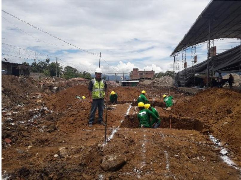
En la fotografía se muestra El proceso de excavación manual de zanjas para zapatas para la cimentación del Bloque N° 04, ambiente destinado para los Servicios Higiénicos de varones y damas
