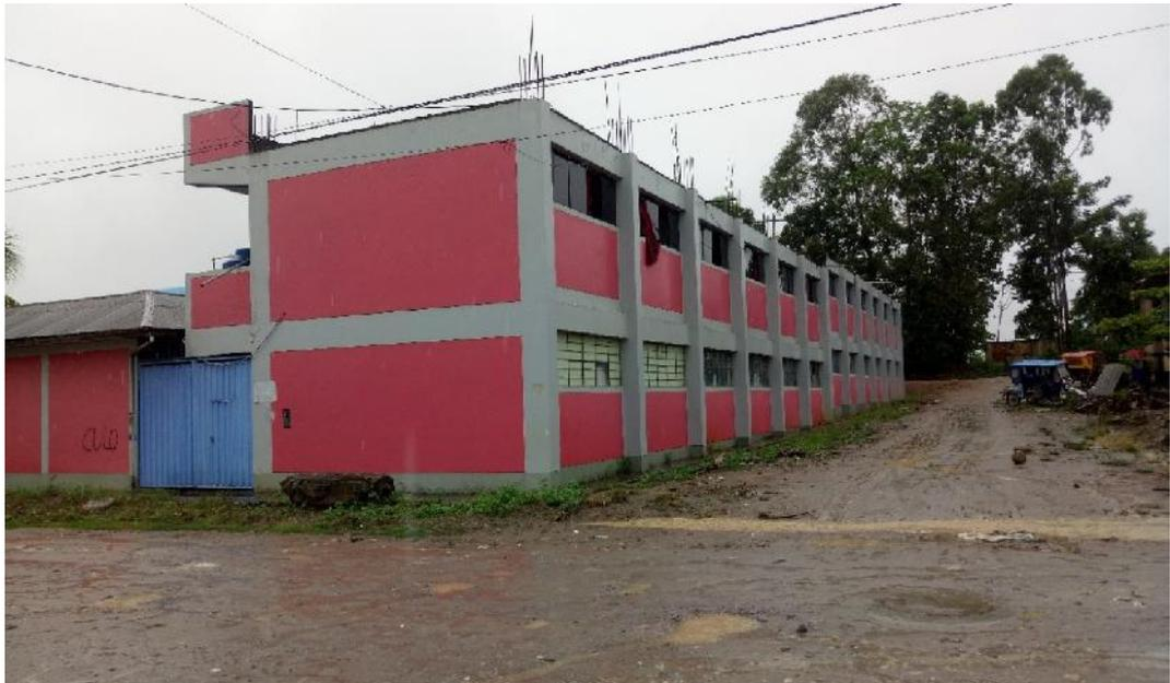
*Figura 4. Ambiente exterior de la institución educativa con la ventanas metálicas y vidrio simple, estas están expuestas siendo necesaria la construcción de un cerco perimétrico.*
