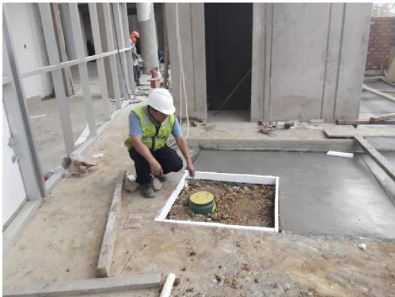
En la fotografía se visualiza pozo a tierra debidamente instalado
