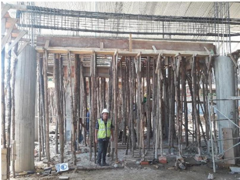
En la fotografía se muestra la verificación y control de los trabajos de encofrado de losas aligeradas
