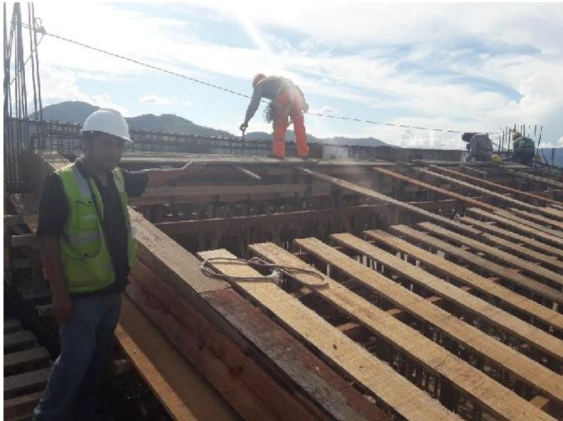
En la fotografía se muestra El proceso de confinamiento de estribos en viga peraltada, por tratarse de trabajo de altura se exigió la instalación de línea de vida y uso de arnés obligatoriamente
