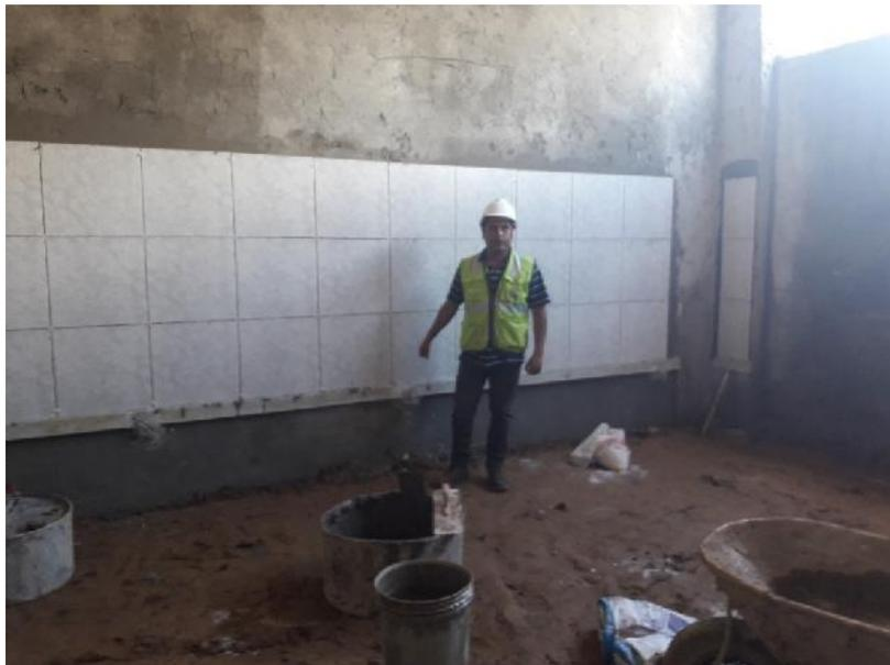
En la fotografía se muestra la verificación de los trabajos de enchapado de sócalos en servicios higiénicos Bloque N° 04
