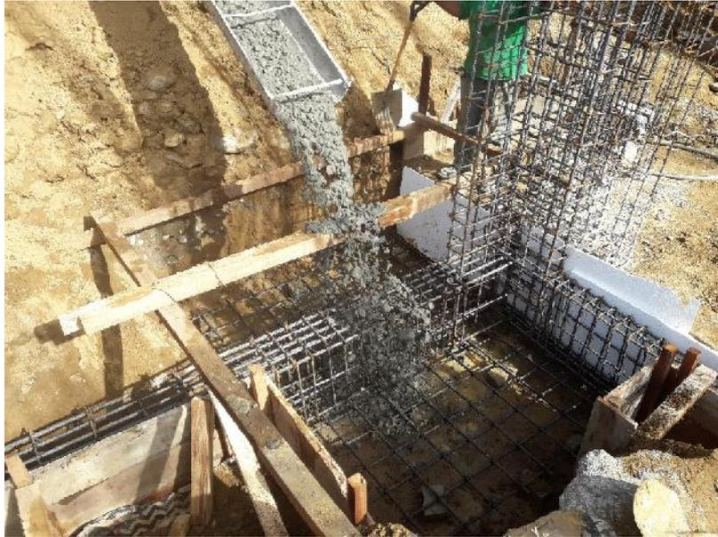
Llenado de concreto  $f'c = 210 \text{ kg/cm}^2$  en zapatas, cabe resaltar que el concreto es premezclado se tomaron las muestras respectivas y se moldearon las probetas para su análisis.
