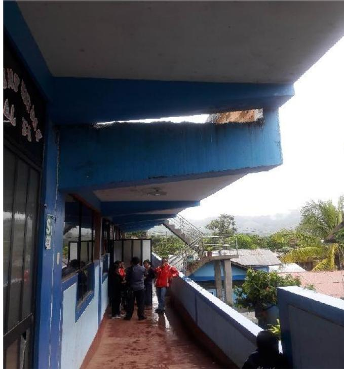
*Figura 11.* Ambiente interior del pabellón y las zonas de circulación libres, también se observa el desnivel que existe entre losas de dos ambientes diferentes.
