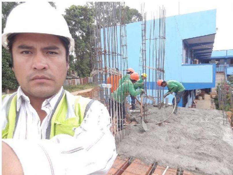
En la fotografía se muestra El proceso de llenado de concreto  $f'c= 210 \text{ kg/cm}^2$  en losa aligerada del Bloque N° 01 del terreno 01, los ambientes serán destinados para laboratorios
