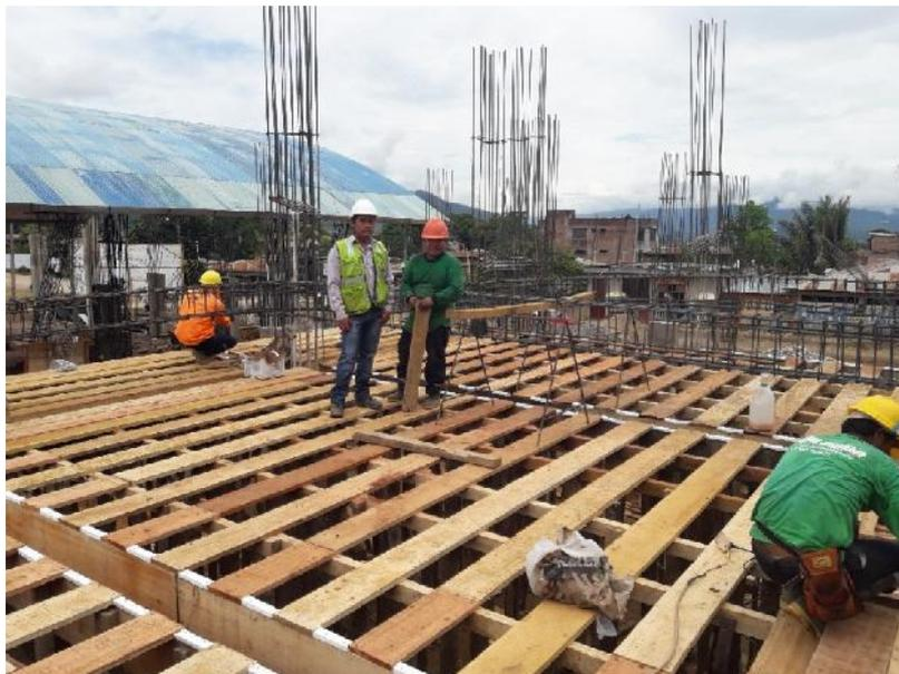
En la fotografía se muestra El proceso de encofrado de losa aligerada y los trabajos de fiertería en el Bloque N° 01 del terreno 01, los ambientes serán destinados para laboratorios
