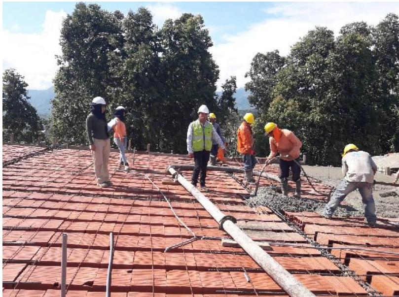
En la fotografía se muestra El proceso de llenado de concreto  $f'c = 210 \text{ kg/cm}^2$  en losa aligerada del Bloque N° 02 terreno 01, los ambientes serán destinados a oficinas administrativas
