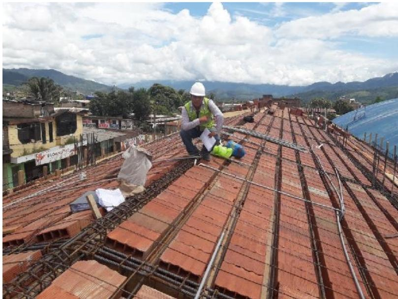
En la fotografía se muestra el proceso de verificación con los planos respectivos de instalaciones eléctricas y fierro de losa aligerada de los bloques 4 y 5 del terreno 01
