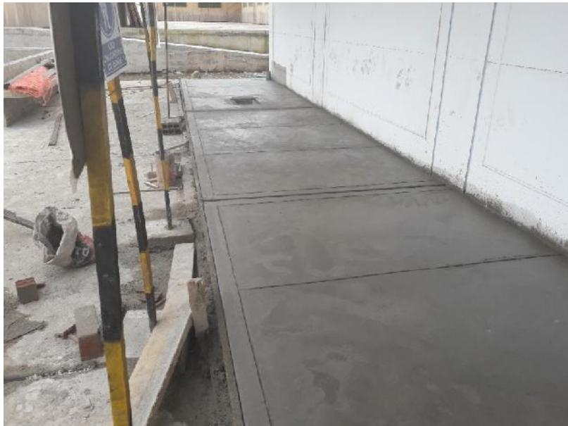
En la fotografía se muestra la conformación de veredas con concreto  $f'c = 175 \text{ kg/cm}^2$  y su bruñado respectivo
