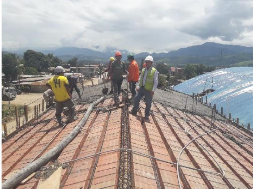
En la fotografía se muestra El proceso llenado de concreto  $f'c = 210 \text{ kg/cm}^2$  pre mezclado en losa aligerada a dos aguas de los Bloques N° 04 y 05 del terreno 01
