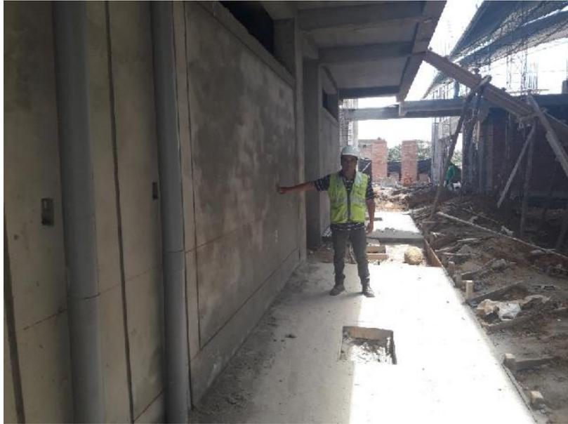
En la fotografía se muestra la verificación de los trabajos de tarrajeo en muros exteriores y bruñado respectivo Bloque N° 05
