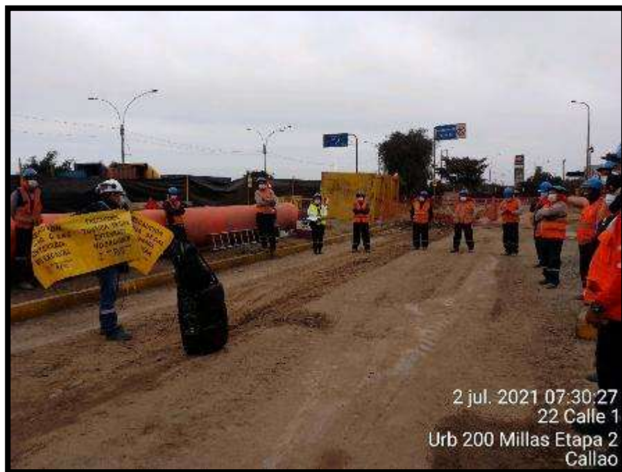
Fig.04.- Se realizarán capacitaciones por parte de la empresa de GAS CALIDDA , debido a que se habían encontrado muchas interferencias en los tramos a laborar.
