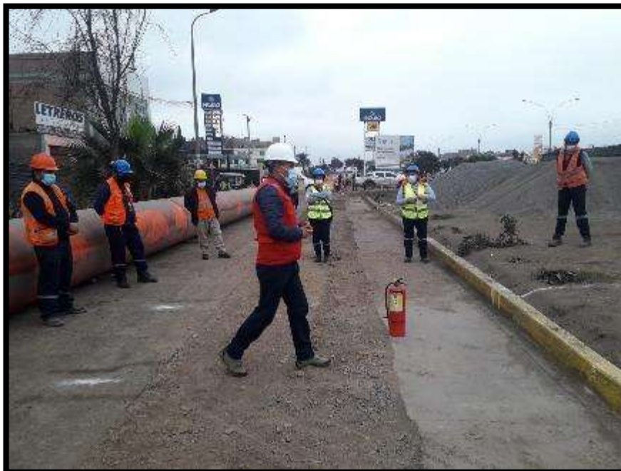
Fig.06.- Se brindarán capacitaciones del uso adecuado del extintor, frente a un caso de emergencia.
