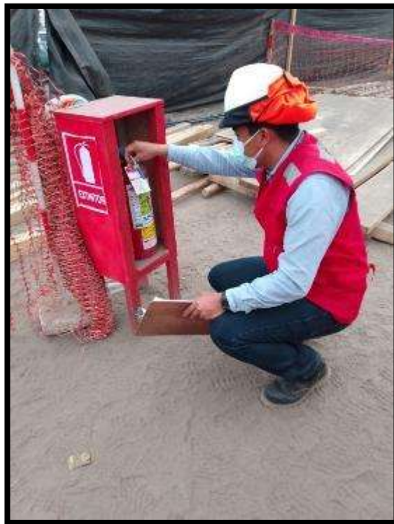
Fig.16.- Se realizó el trabajo de inspección de los extintores en las áreas de trabajo.
