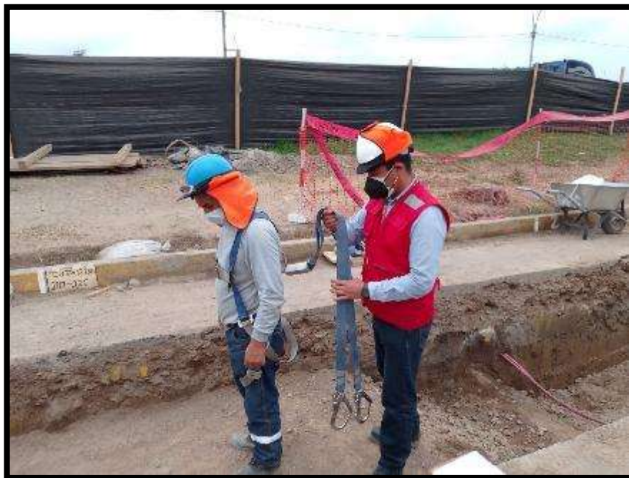
Fig.14.- Se realizó inspección del uso adecuado del arnés en campo al personal que labora en la obra.
