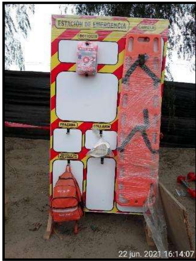
Fig.11.- Se implemento la estación de emergencia, frente a cualquier emergencia.
