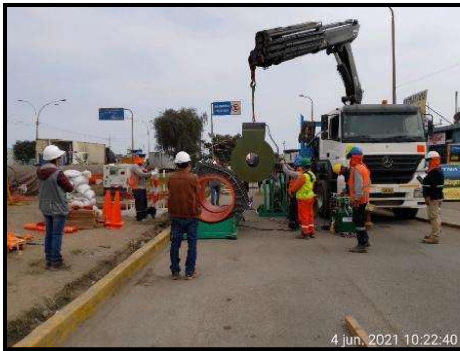
Fig.02.- Se realizarón trabajos en caliente, previo a realizar la actividad, se llena el PTAR, se observa la realización de la termofusion con tuberías de 1000mm de diámetro, con el apoyo del camión grúa, en la obra de saneamiento.
