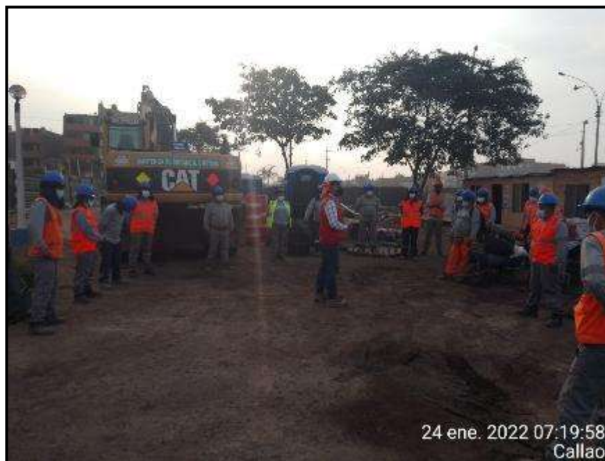
Fig.18.- Se capacitó al personal frente a posibles riesgos y peligros que se dan en obra.
