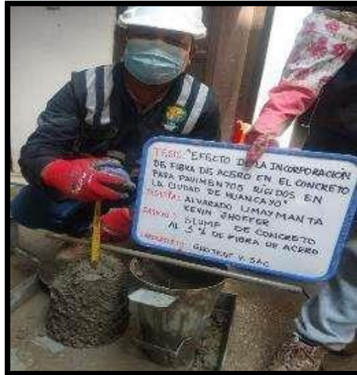
Fotografía 76: Medición del asentamiento del concreto con 3.0 % de fibra de acero en un rango de 3” a 4” según la norma NTP 339.114.
