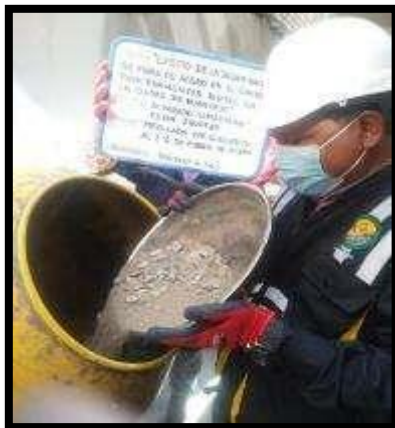
Fotografía 70, Fotografía 71, Fotografía 72 y Fotografía 73: Vista de materiales tales como agregado, cemento, agua y fibras de acero para la elaboración del concreto con 3.0 % de fibra de acero.
