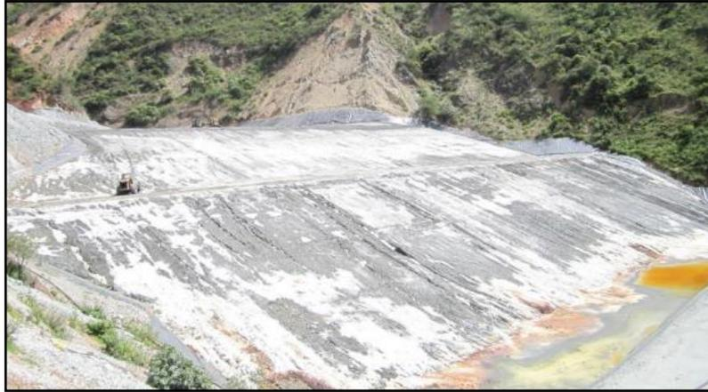
Figura 2.13 Vista Frontal De Un Depósito De Relaves Filtrados
