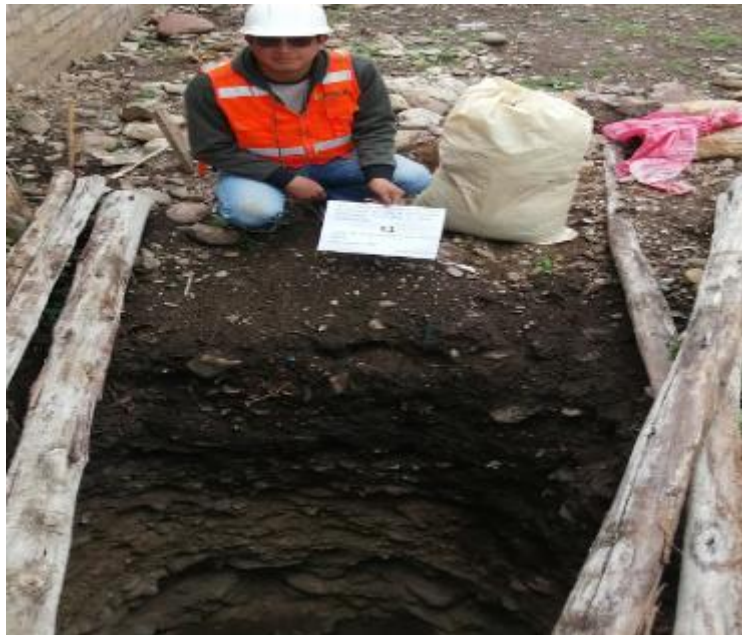
Fotografía 3: Ecavacion de calicata C1
