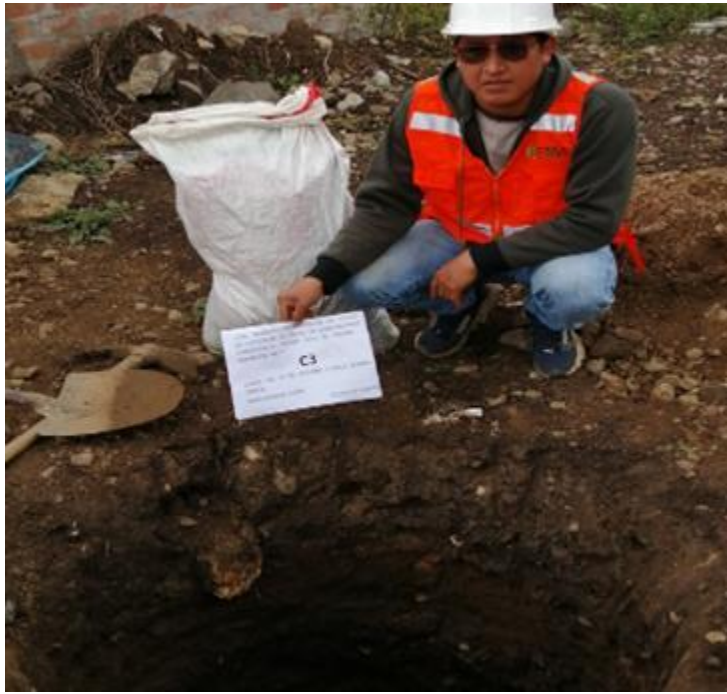
Fotografía 7: Excavación de calicata C3
