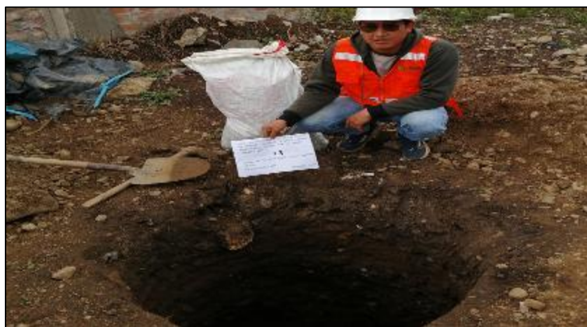
Figura 16: Muestra 1 extraída de calicata C3
