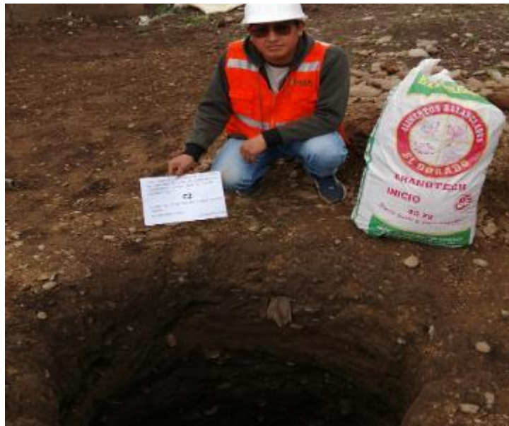
Fotografía 5: Excavación de calicata C2
