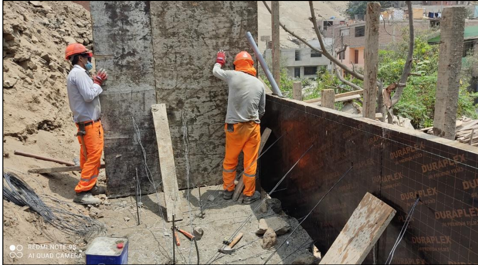
Figura 34: Proceso optimizado de encofrado
