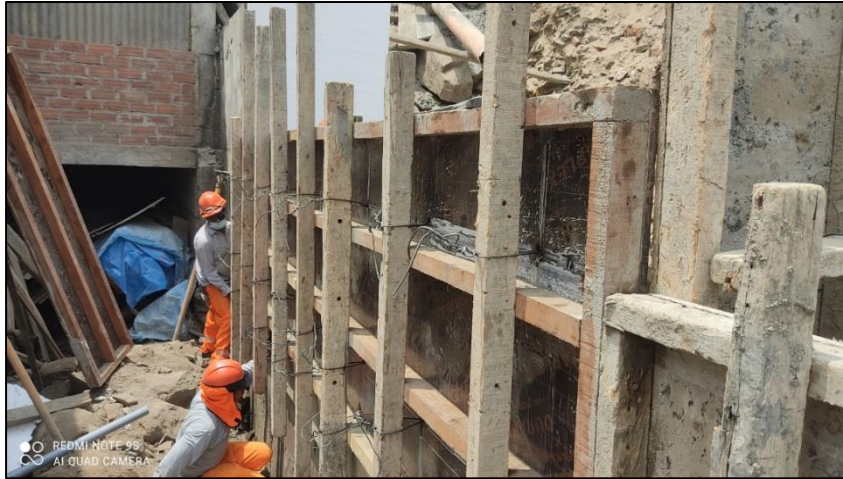
Figura 27: Partida de encofrado y desencofrado de muro de contención.
