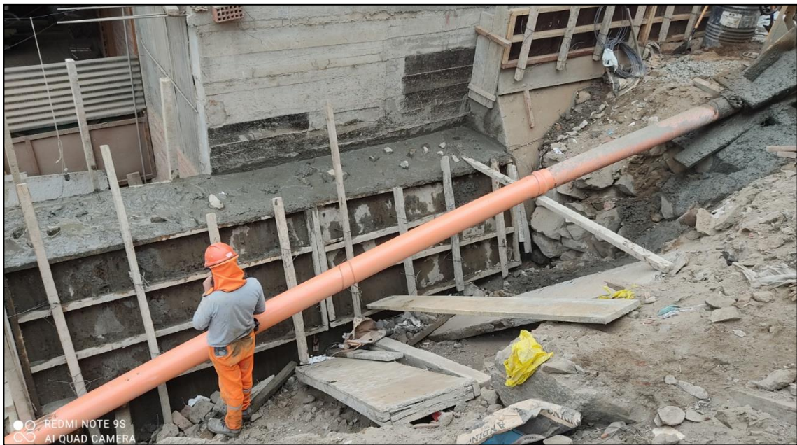
Figura 16: Vaciado de concreto para el muro de contención.
