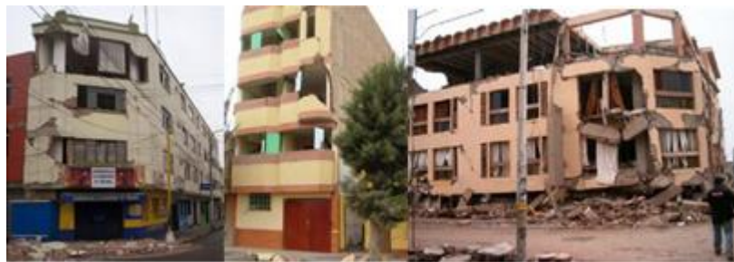
Figura 18 Daños en edificios de concreto armado y albañilería ante el sismo de Ica-2007 Fuente: C.E.R.E.S.I.S., 2008.
