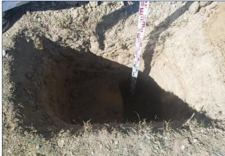
Figura 34. Vista de la calicata.
