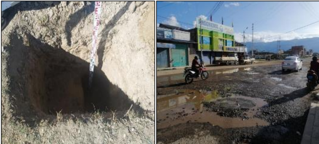
Figura 1. Vista de la calicata suelo arcilloso y de las condiciones de la pavimentación de la zona de estudio.
