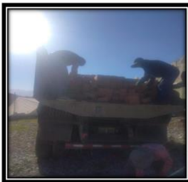
Transporte de los ladrillos a obra
