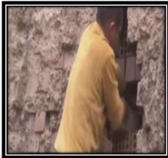
Verificación del respectivo quemado los ladrillos para las ventas
