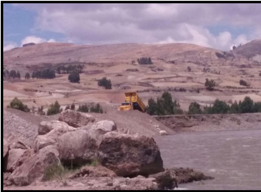
En la imagen se puede observar que el volquete está arrojando los materiales de desecho.
