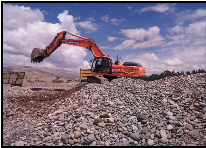
En la imagen se puede observar a la maquinaria que está en plena extracción de agregados.
