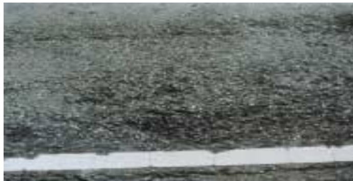
Figura N o 40: Peladura por Interperismo, Nivel de severidad (H)
