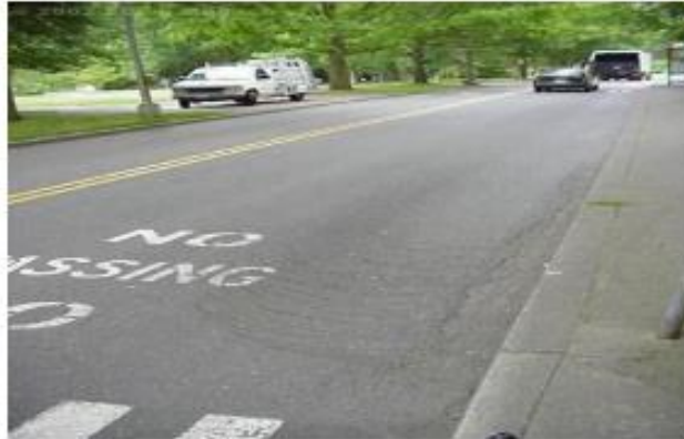
Figura N a 31: Desplazamientos, Nivel de severidad (L)
