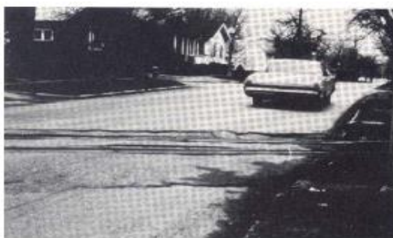
Figura Nª 54: Cruces de sumideros de rejilla (cruces de rieles), Niveles de severidades (H)
