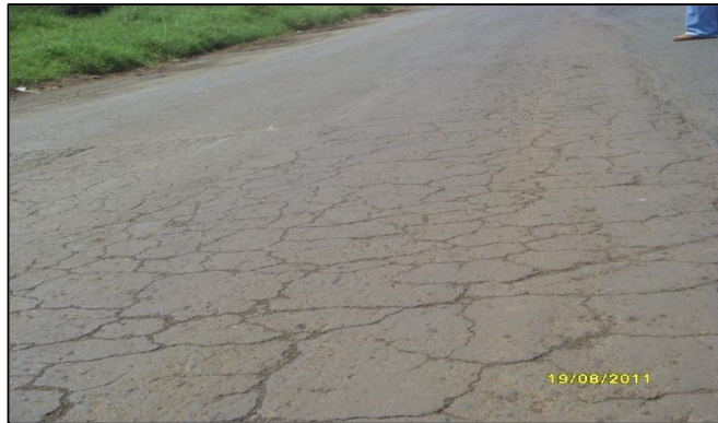
Figura Nª 08: Piel de Cocodrilos, Niveles de severidades (Hs.)
