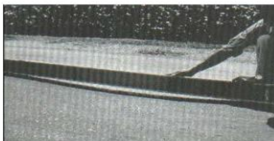
Figura Nª 27: Depresiones, Nivel de severidad (H)
