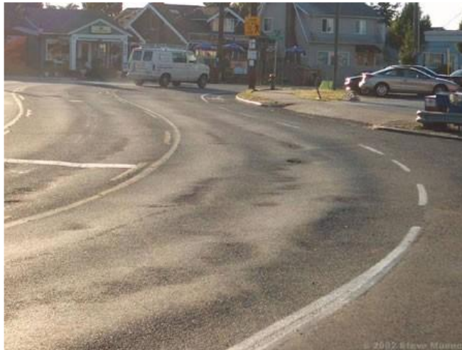
Figura Nª 51: Desplazamiento, Nivel de severidad (M)
