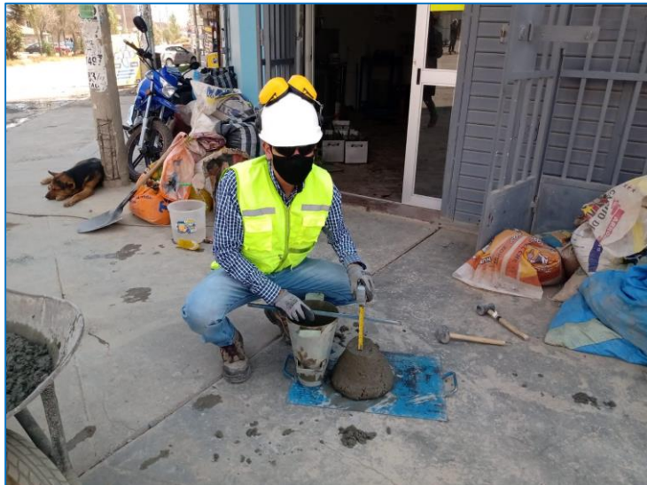
Figura 13: Asentamiento del concreto - NTP 339.035.
