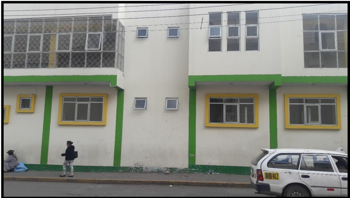
Ilustración 10. Vista hacia el exterior de la edificación en la mayoría de aulas y oficinas
