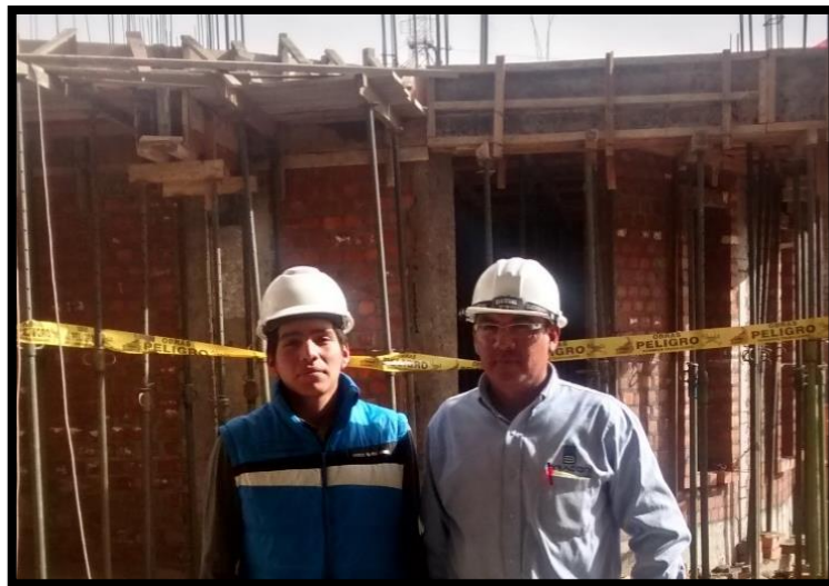
Ilustración 122. Presencia de Residencia durante ejecución de estructuras y demás
