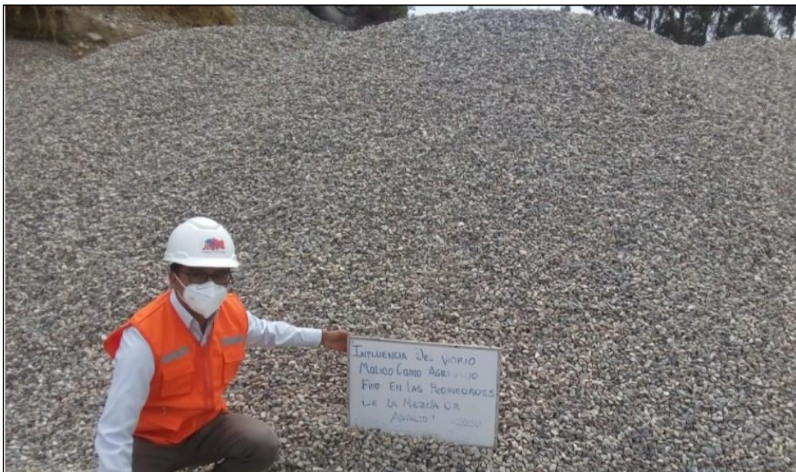
Fotografía 2. Extracción de los agregados gruesos.
