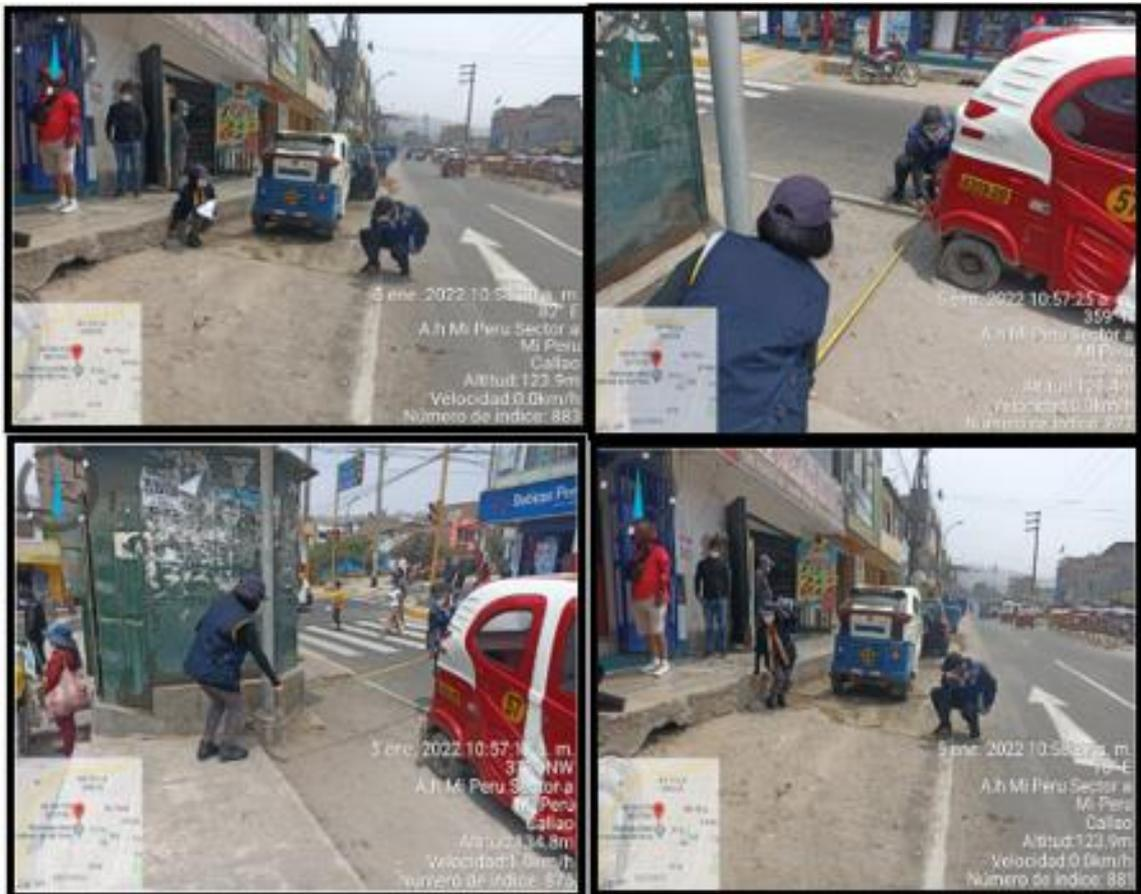
La Av. Trujillo, tiene una sección vial de 18.70 m, la vía en el sentido S-N, tiene 02 carriles de circulación con un ancho de calzada de 6.00m, con una berma de 9.00m y vereda de 1.20m en el sentido N-S, la vía carece de señalización vertical, y falta mantenimiento en las marcas en el pavimento, es decir, la señalización horizontal.
