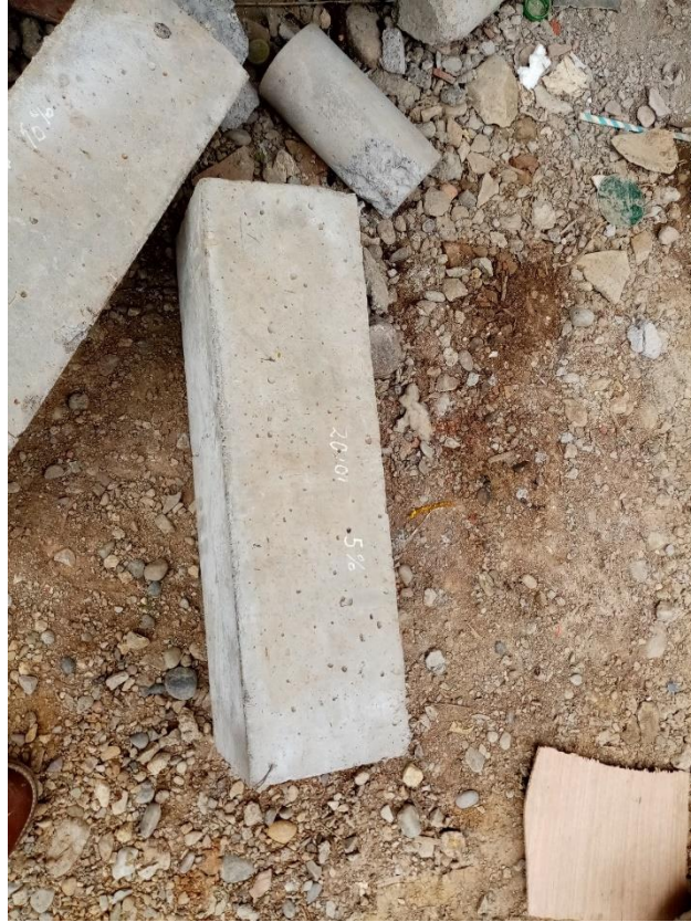
Fotografía 17. Viguetas de concreto.
