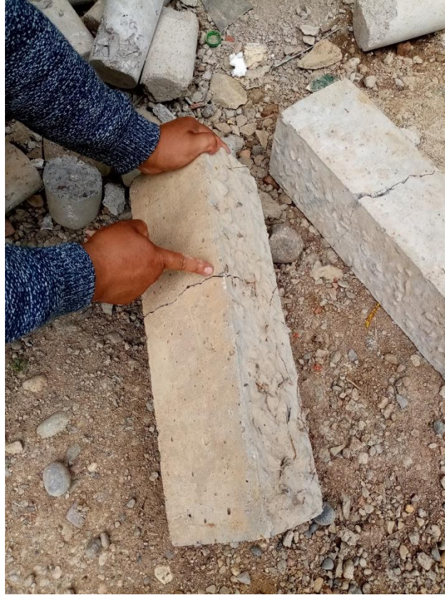
Fotografía 21. Fisura en la vigueta de concreto con 15 % de FMLR.
