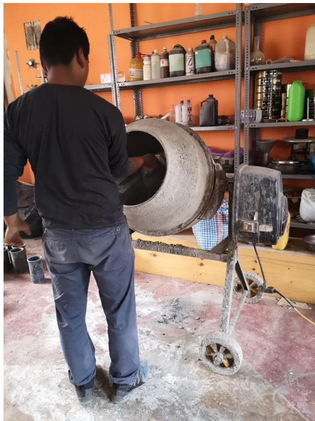
Fotografía 7. Mezclado de los componentes del concreto.
