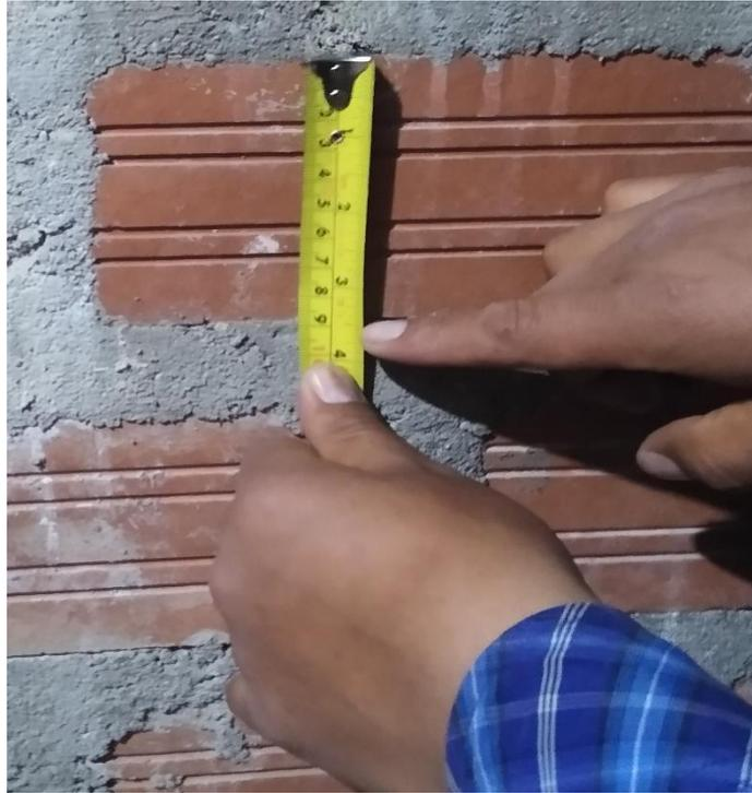
*Fotografía 7. Medida de ancho del ladrillo 11 c.m.*
