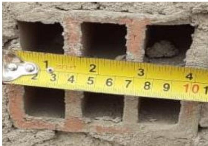
*Fotografía 8. Ancho de mortero vertical 2.2 c.m.*
