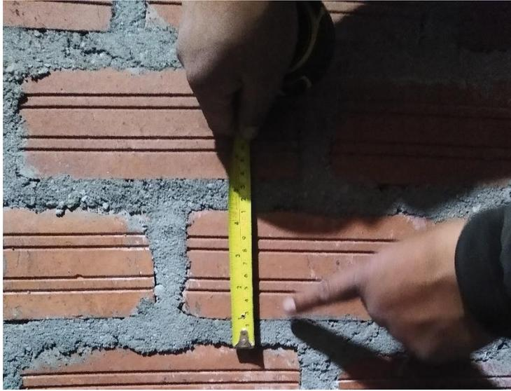
*Fotografía 9. Ancho de mortero vertical 2.2 c.m.*
