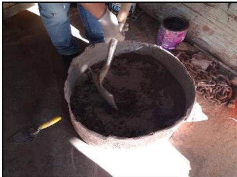
**Fotografía N° 16:** “Incorporación de agua en la mezcla, se mezcló hasta observar homogeneidad Fuente: elaboración propia.”
