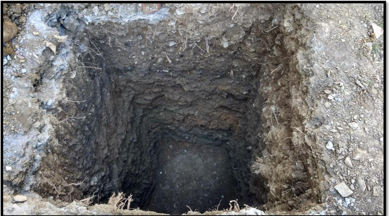
**SE OBSERVA EN LA IMAGEN Nro. 04 LA CULMINACION DEL POZO A TIERRA EN MEDIDAS CONSIDERADAS SEGÚN EL EXPEDIENTE A UNA PROFUNDIDAD DE 2.80M**
