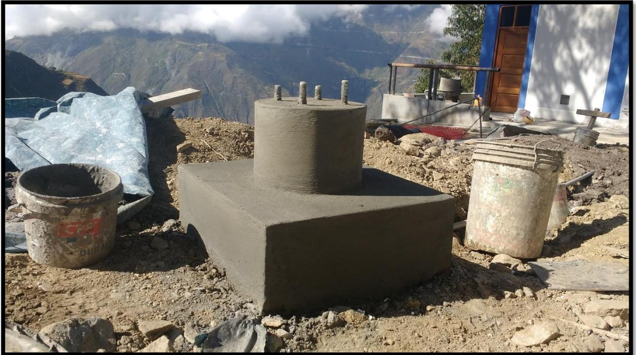
**SE OBSERVA EN LA IMAGEN NRO. 14 LA CONSTRUCCION DE PILARES DE SOPORTE (DADOS) PARA LOS POSTES DE FAROLES DE ALUMBRADO INTERIOR.**
