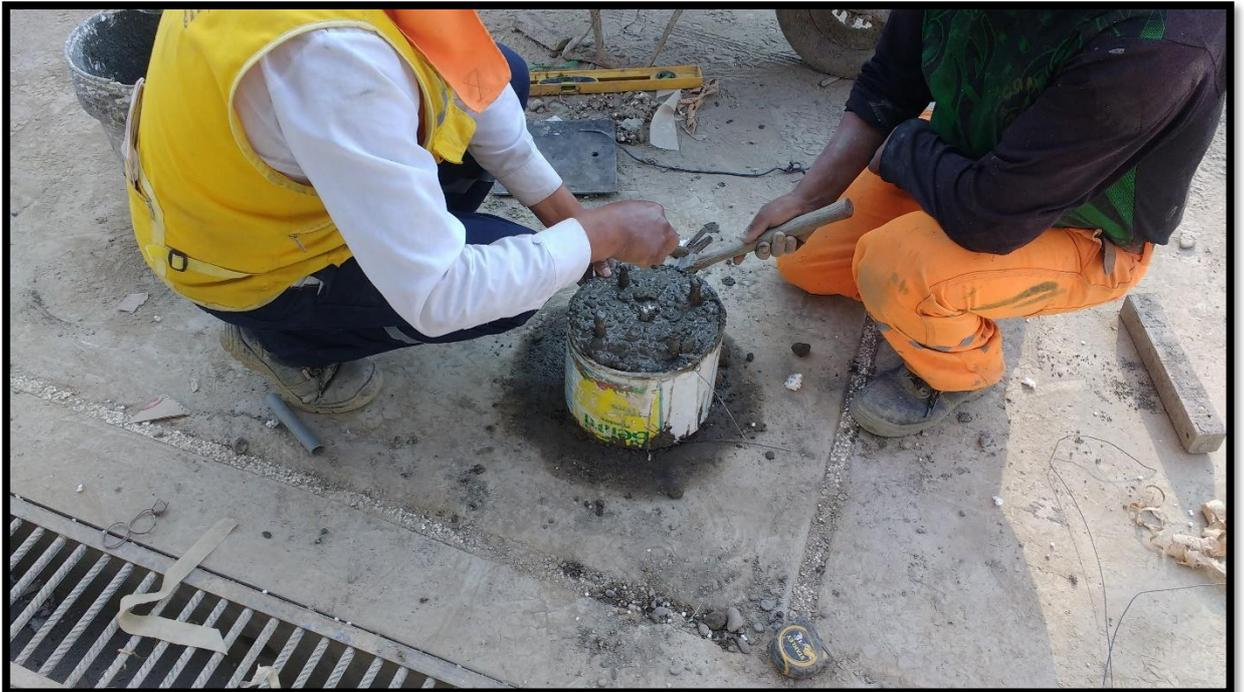
**SE OBSERVA EN LA IMAGEN Nro. 08 EL PROCESO CONSTRUCTIVO DE DADOS DE CONCRETO PARA EL SOPORTE DE LOS POSTES QUE CONTENDRAN LOS FAROLES DE ALUMBADO GENERAL**
