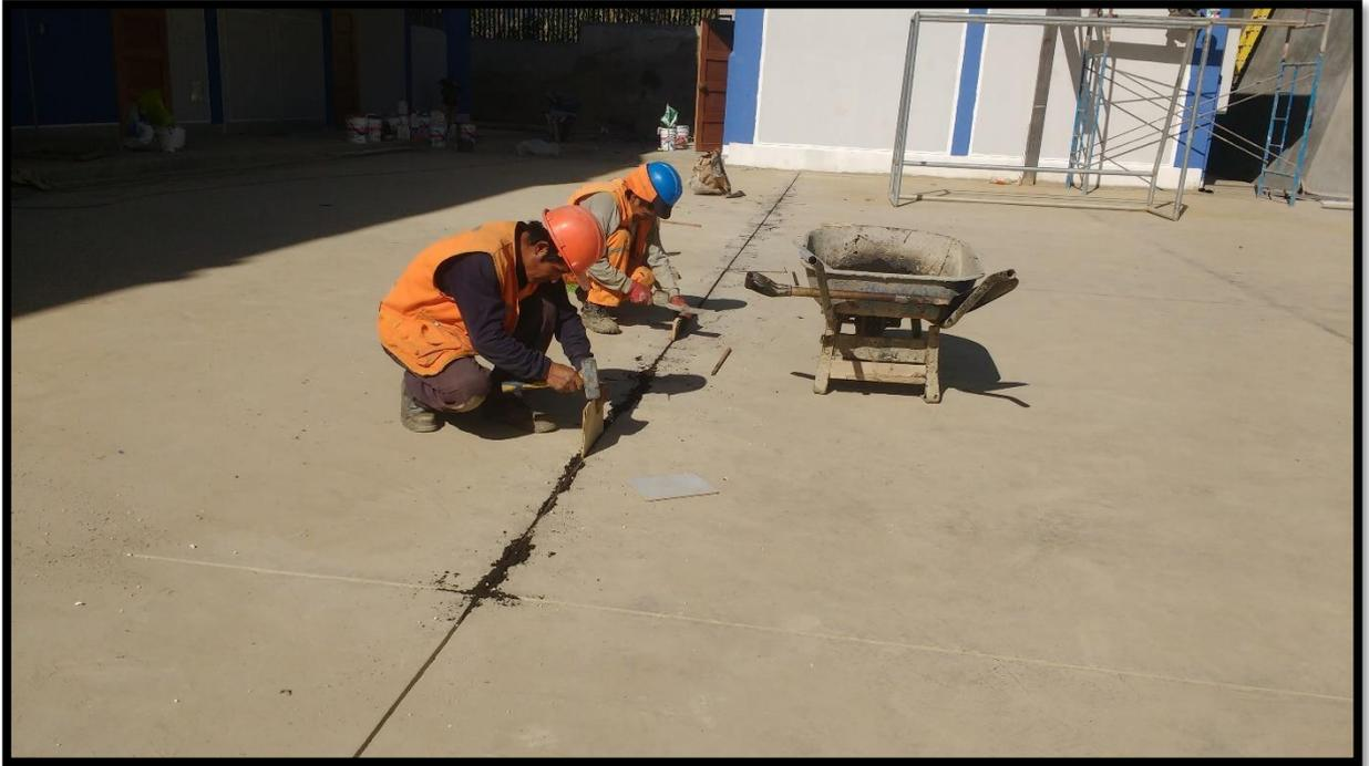
**SE OBSERVA EN LA IMAGEN NRO. 15 SELLADO DE JUNTAS DE DILATACION DE LA LOSA DEPORTIVA, CUNETAS, RAMPA CON ASFALTO RC-250 Y ARENA GRUESA RESPECTIVAMENTE.**
