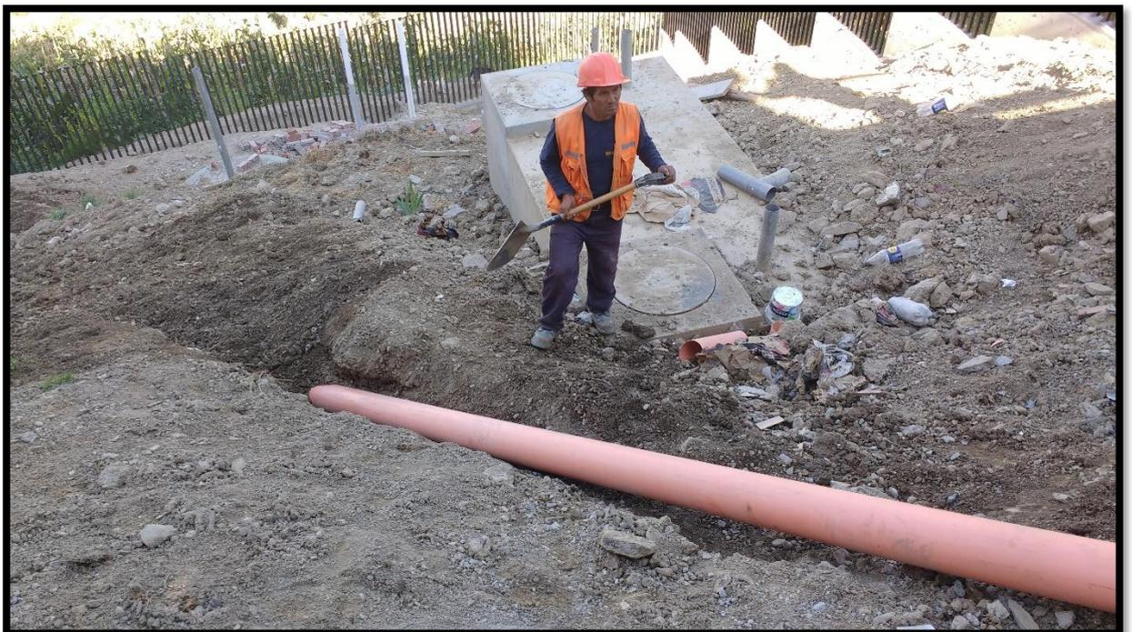
***SE OBSERVA EN LA IMAGEN Nro. 02 LA COLOCACION DE LAS REDES QUE DESEMBOCARAN EN LAS MATRICES DE ALCANTARILLADO EXISTENTES***
