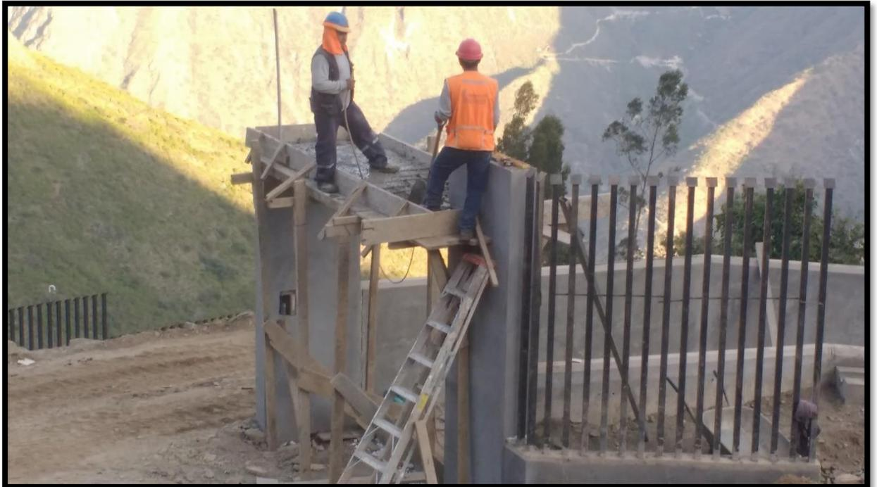
***SE OBSERVA EN LA IMAGEN Nro. 01 CULMINANDO LOS TRABAJOS DE ENCOFRADO Y COLOCADO DE CONCRETO EN LA LOSA ARMADA DEL INGRESO PRINCIPAL***
