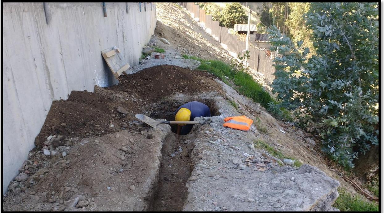
**SE OBSERVA EN LA IMAGEN Nro. 03 LA CUADRILLA DE EXCAVACION DE ZANJA PARA LA EL POZO A TIERRA**
