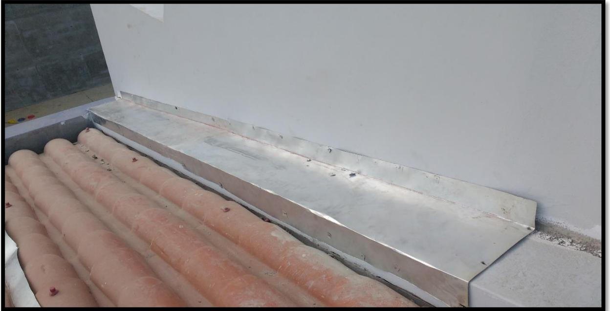
**SE OBSERVA EN LA IMAGEN NRO. 17 LA ACCION DE COLOCACION DE PLANCHAS GALVANIZADAS EN LAS JUNTAS DE DILATAION ENTRE LOS BLOQUES DE LA INFRAESTRUCTURA, EN TODA LA COBERTURA DEL TECHO.**
