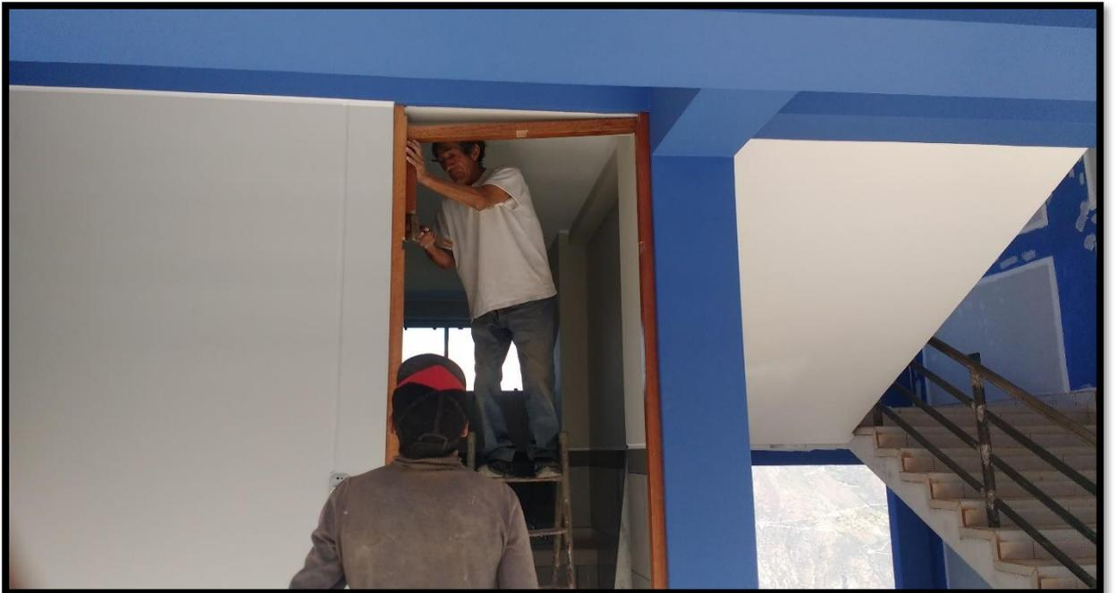
***SE OBSERVA EN LA IMAGEN Nro. 06 AL PERSONAL DE TRABAJO REALIZANDO LA PARTIDA DE COLOCACION DE PUERTAS EN LOS AMBIENTES DE LA INFRAESTRUCTURA, CON EL DEBIDO PROCESO CONSTRUCTIVO MANDADO EN LAS ESPECIFICACIONES TECNICAS***
