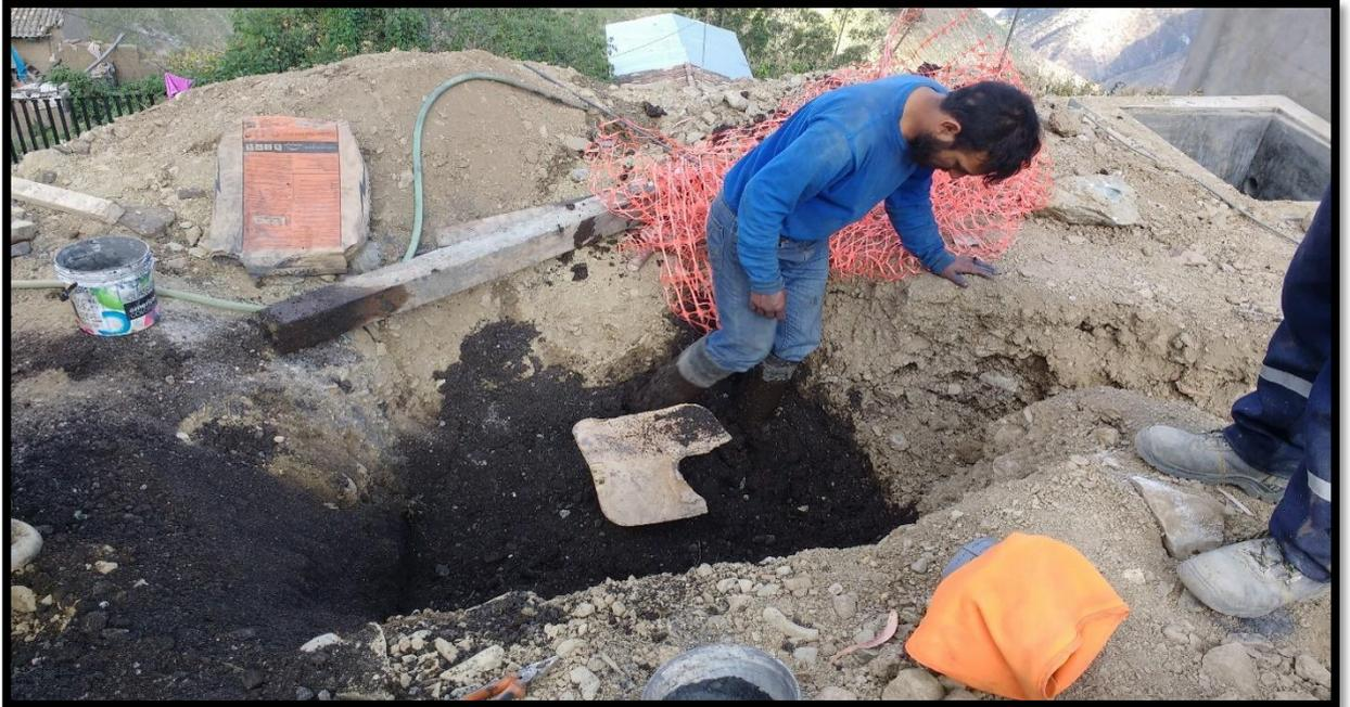
**SE OBSERVA EN LA IMAGEN Nro. 11 LA INCORPORACION DE MATERIALES COMO BENTONITA, CEMENTO CONDUCTIVO, MATERIAL ORGANICO Y LA VARILLA DE COBRE QUIENES SERAN LAS QUE MANTENGAN A LA INFRAESTRUCTURA LIBRE DE DESCARGAS ELECTRICAS**
