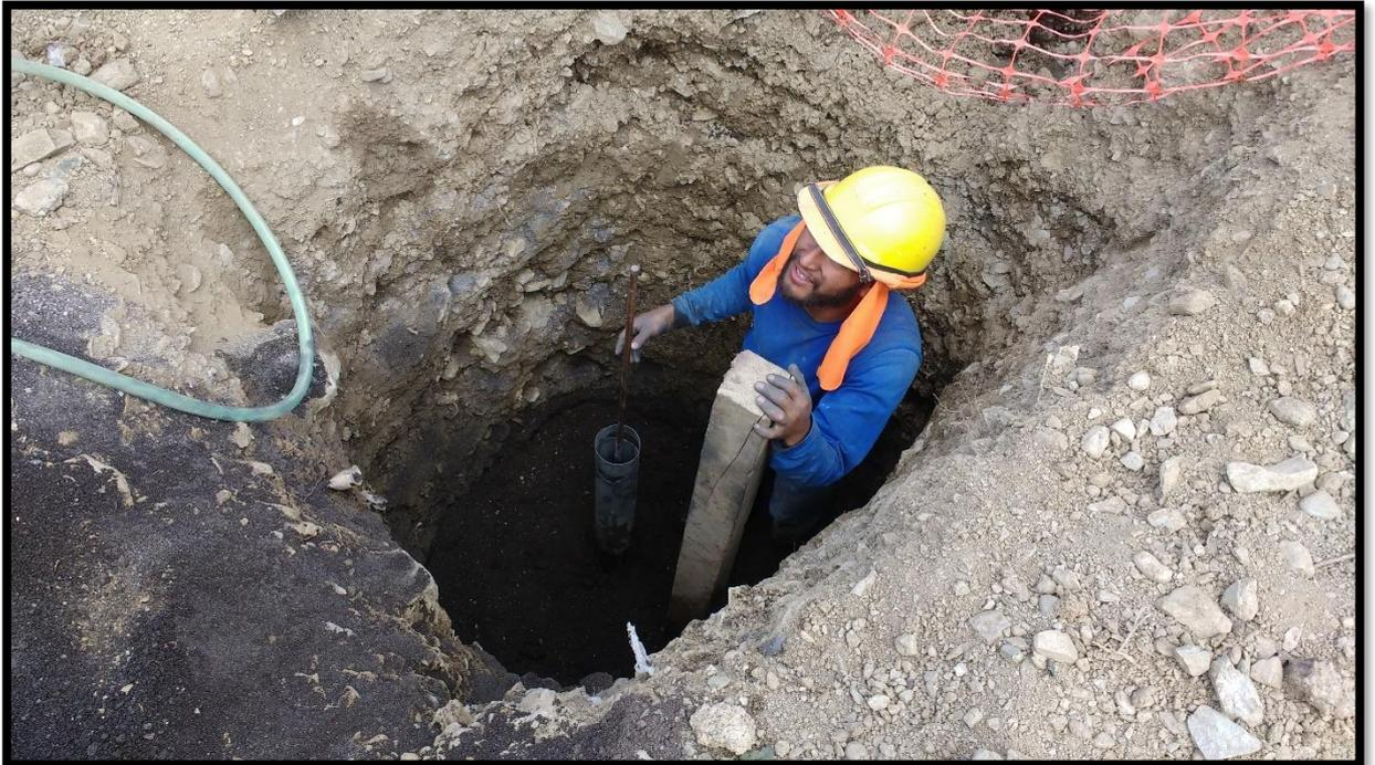
**SE OBSERVA EN LA IMAGEN Nro. 10 AL PERSONAL ENCARGADO DE INSTALACIONES ELECTRICAS PREPARANDO TERRENO PARA LA PUESTA A TIERRA**
