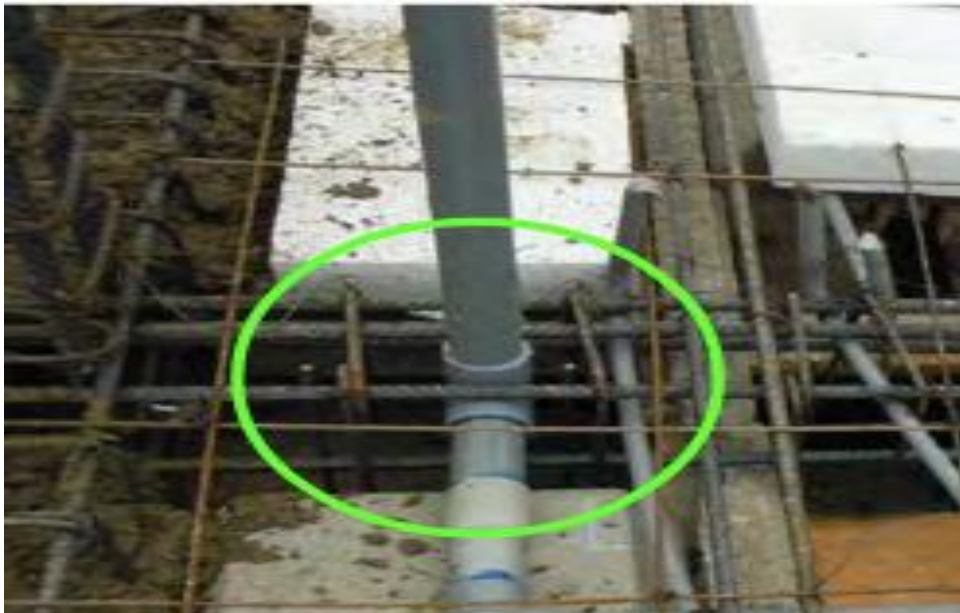
Figura 4 Tuberías a Través de Vigas.
