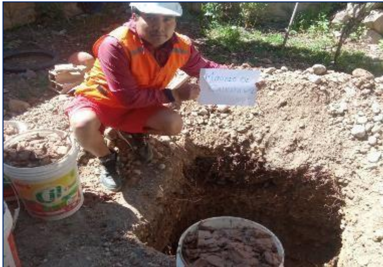
Fotografía 1. Extracción de las muestras en calicata.
