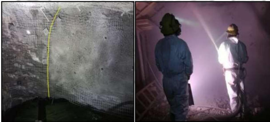
Figura 14: En la imagen izquierda tenemos la línea divisoria del avance de SH. En la imagen derecha se observa el lanzamiento de Shotcrete con aliva (vía seca).
