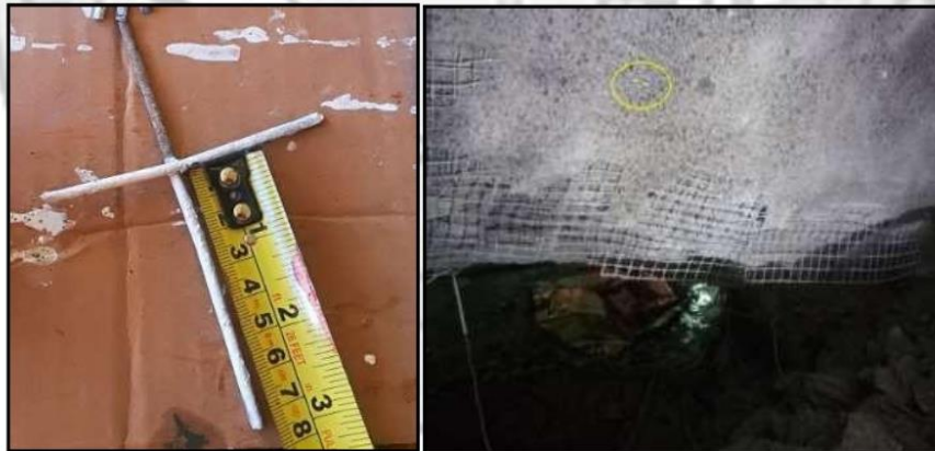
Figura 16: En la imagen izquierda tenemos calibrador de 3pulg(7.5cm). En la imagen derecha se observa el calibrador que controla el espesor de SH hasta cubrir toda la malla
