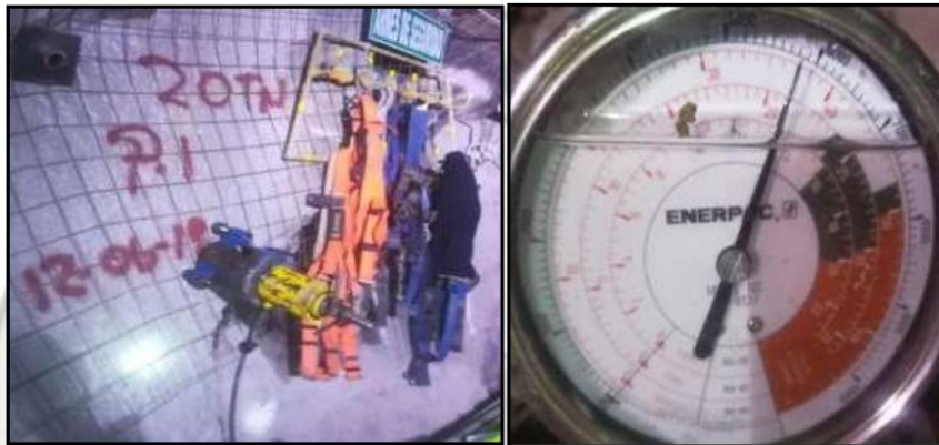
Figura 19: En el hastial derecho de la cámara para Tolva de la Ch 1757 se realizó la prueba de arranque al Perno Helicoidal "P1" colocado hace más de un mes. El resultado fue de 20 Tn realizado por el proveedor CASTEM en compañía del geomecánico y jefe de guardia de SEPROCAL.
