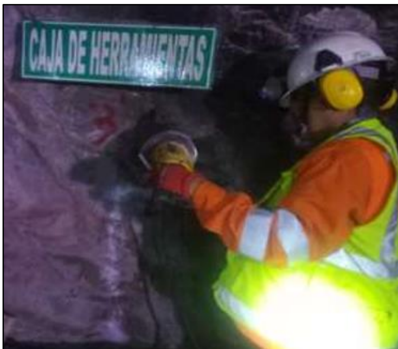
Fotografía. 6. En el hastial derecho se colocó PH de sólo 4 pies (Mecha en el Collarín) con 2 resina. A los 10 minutos se realizó la prueba de arranque.
