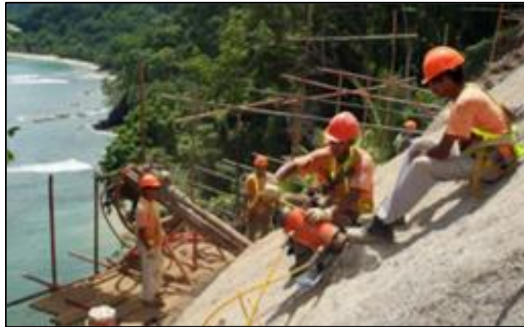
Ilustración 9. Tensado de Anclaje
