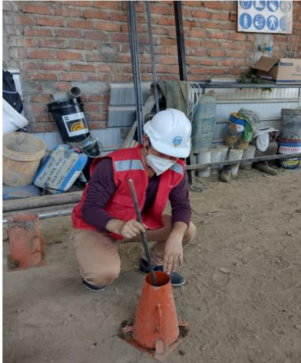
Figura 10: Medición de la consistencia de concreto.
