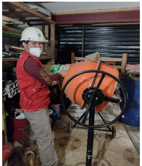
Figura 9: Vaciado de vidrio molido en el trompo.
