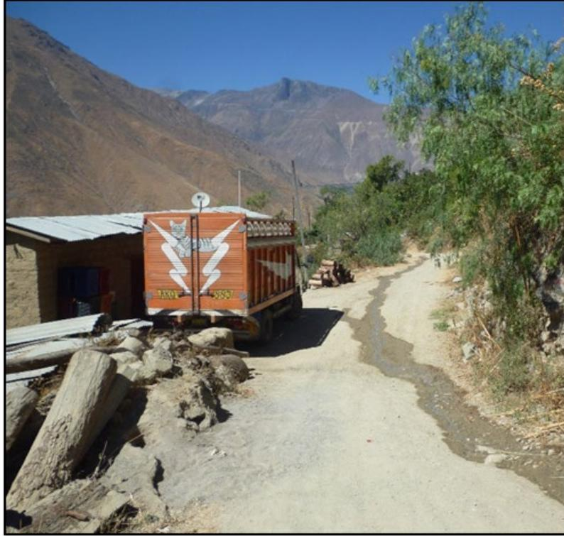
Fotografía 7. Vista del agua proveniente de la colmatación de una cuneta.
