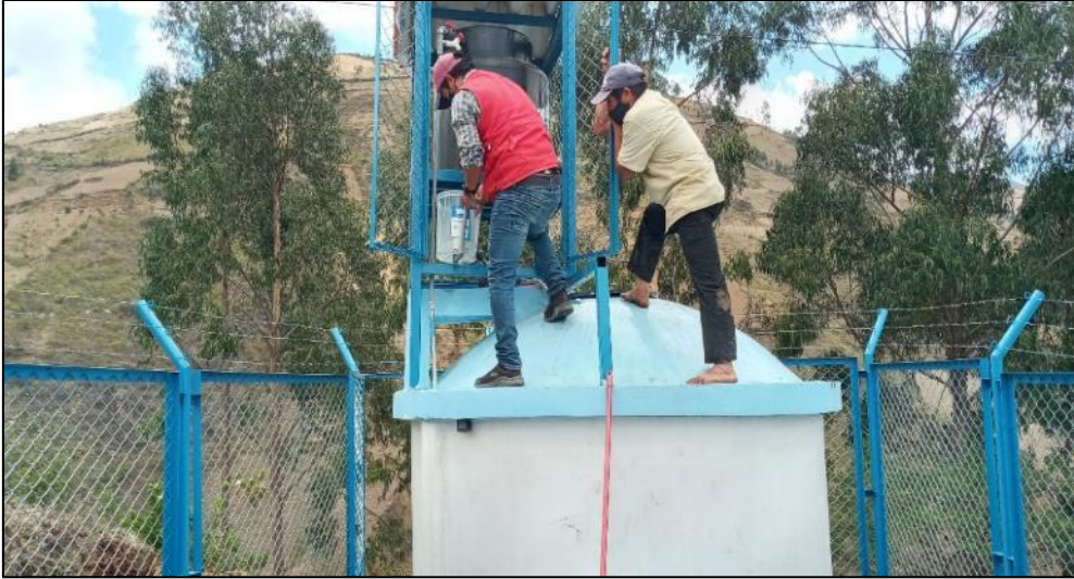
Fotografía 11. Vertimiento de la solución madre en el reservorio del caserío Yahuangate.
