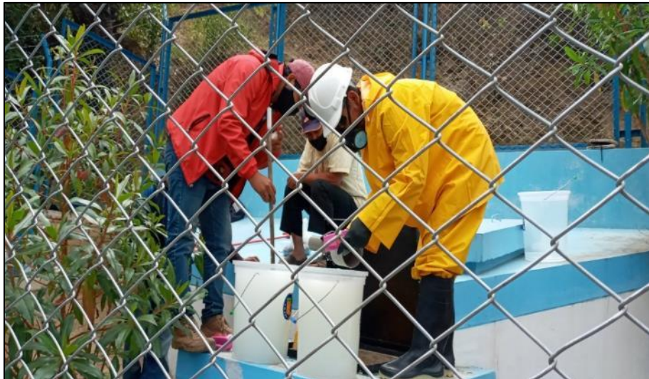
Fotografía 10. Vista de la preparación de la solución madre de cloro en el caserío Yahuangate.
