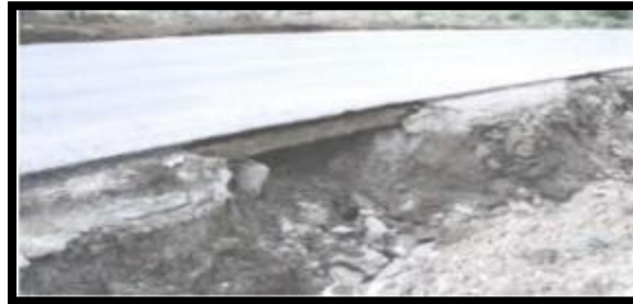
Figura 3 :Estabilización con cal
