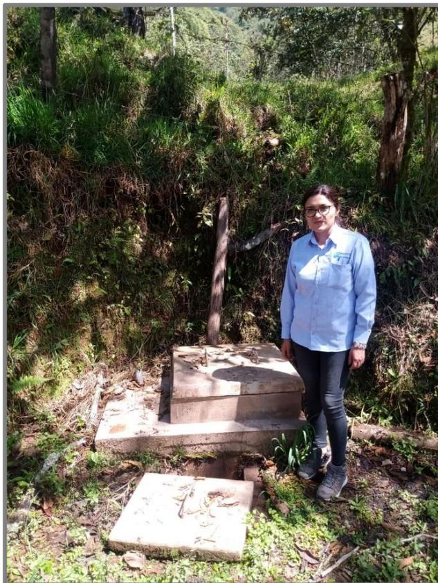
Figura 22 Cámara Rompre Presión Tipo 6
