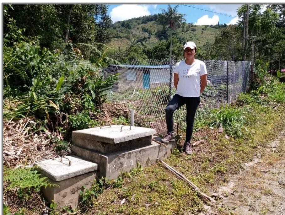
Figura 23 Cámara Rompre Presión Tipo 7
