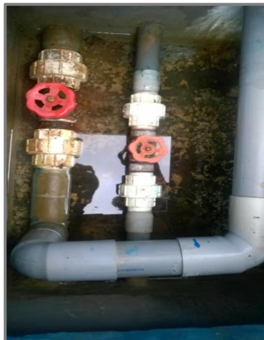
Figura 27 Accesorios en la cámara de válvulas..
