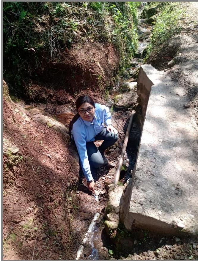
Figura 24 Tubería expuesta en línea de distribución
