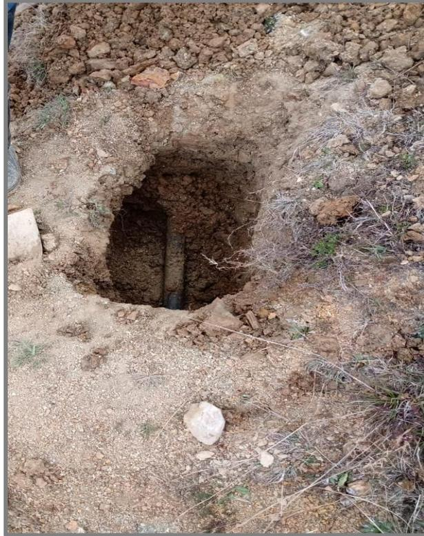
Figura 28 Excavación para la revisión de la tubería en la línea de conducción.
