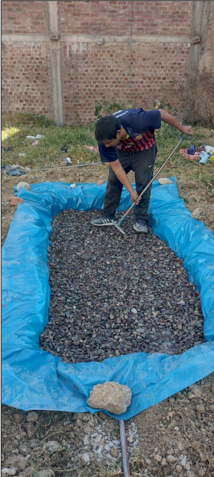
Fotografía 4. Relleno de grava de 1" a 1/2" en la base del humedal artificial. 12
