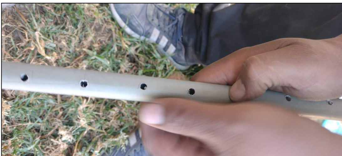
Fotografía 3. Perforación de tubería para salida de aguas grises.
