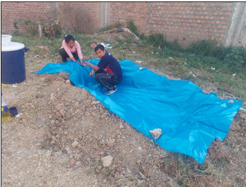
Fotografía 2. Colocación de material referido al geotextil en el humedal artificial.
