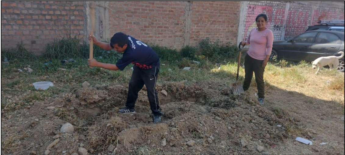
Fotografía 1. Vista de la excavación para el humedal artificial a escala.
