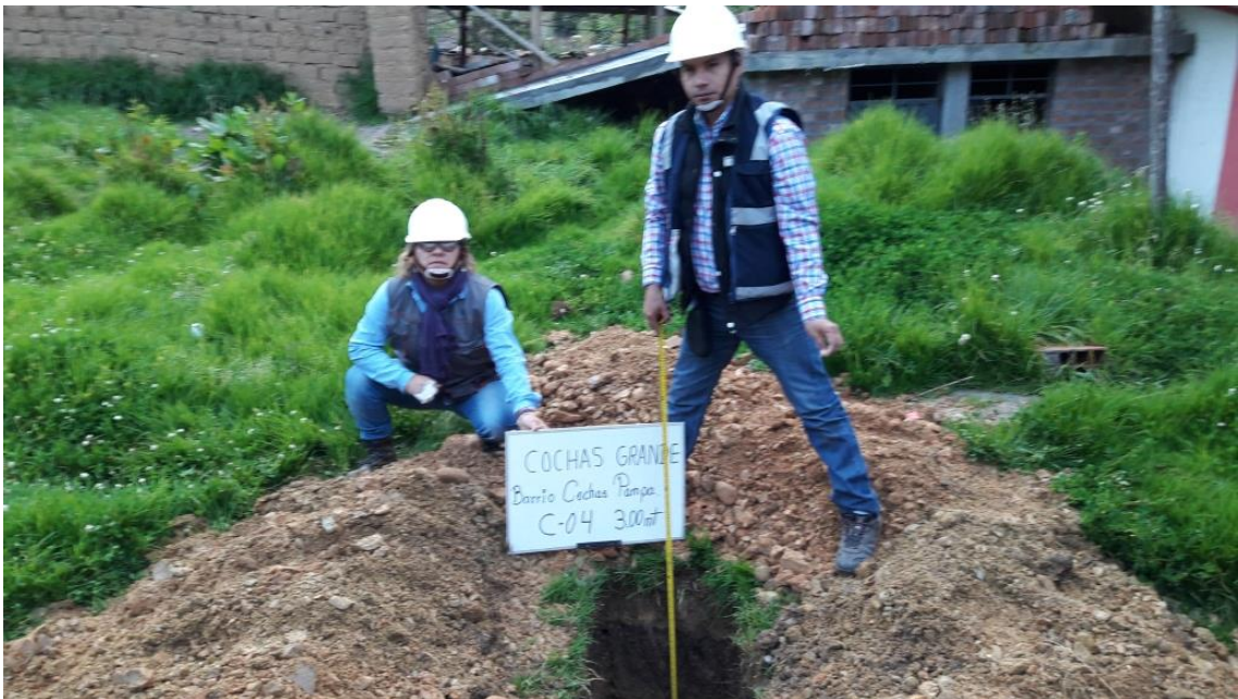
Figura 91. Excavación de la calicata 04 desde otra perspectiva.
