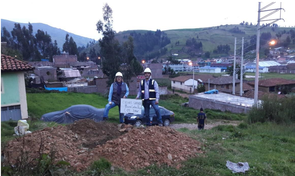
Figura 97. Excavación de la calicata 09.
