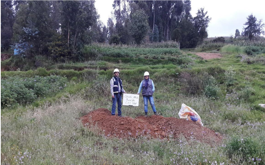
Figura 94. Excavación de la calicata 07.
