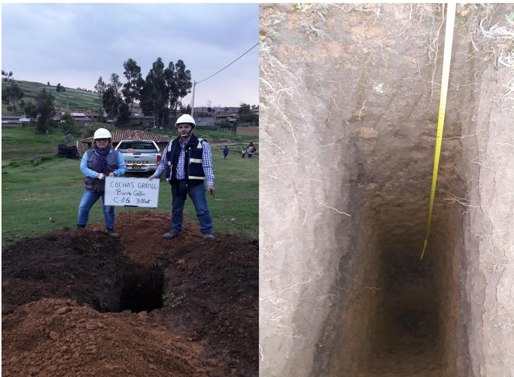
Figura 93. Excavación de la calicata 06.
