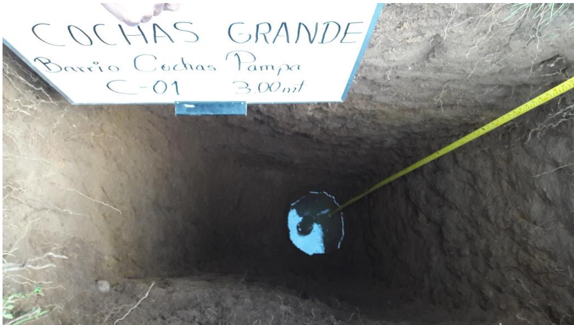
Figura 88. Excavación de la calicata 01.
