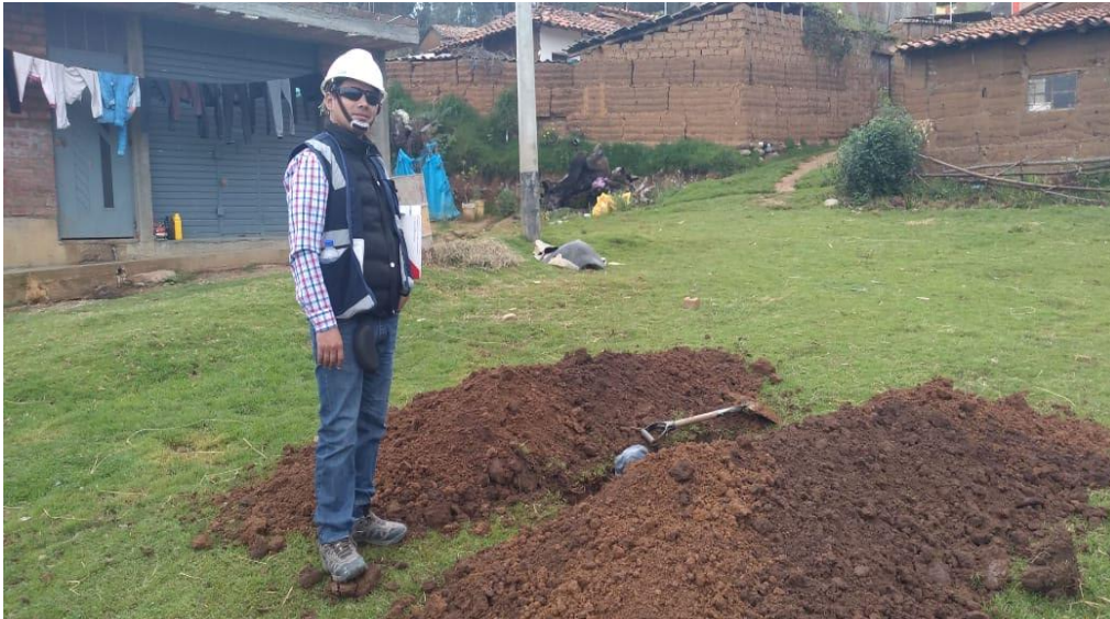
Figura 92. Excavación de la calicata 05.
