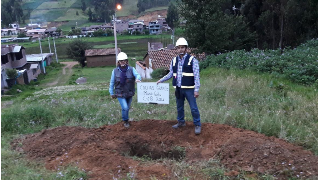
Figura 96. Excavación de la calicata 08.
