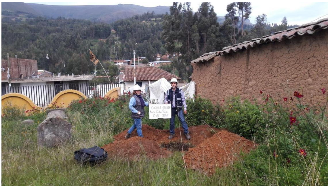
Figura 89. Excavación de la calicata 02.
