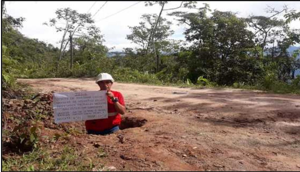
Se realiza la excavación de la segunda calicata en la progresiva 02+000 del tramo San Juan de Perene – el pajonal.
