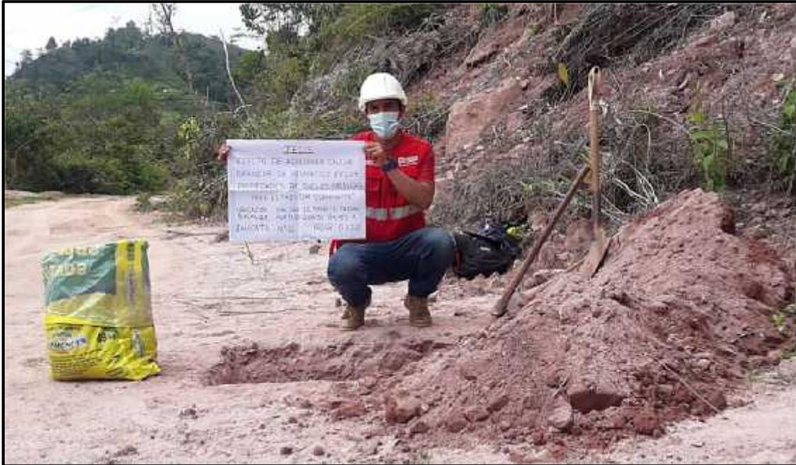
Se realizó la primera excavación de la primera calicata en la progresiva 1+000 para la obtención de muestras.
