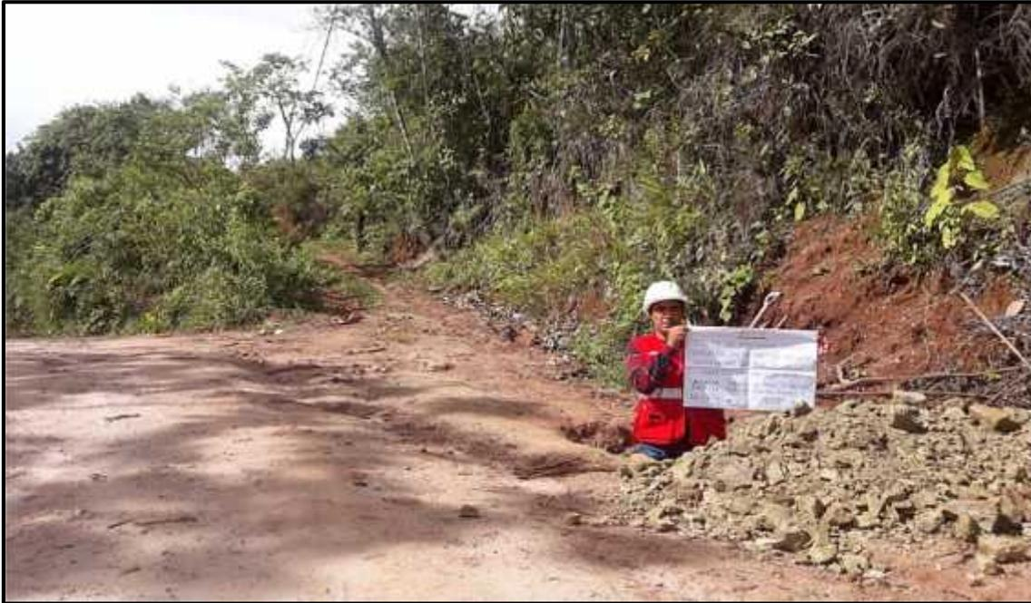
Se realiza la excavación de la segunda calicata en la progresiva 03+000 del tramo San Juan de Perene – el pajonal.
