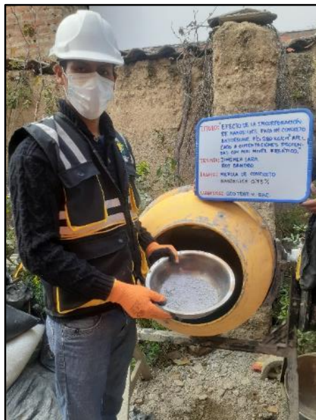
Fotografía N° 34: Vista de materiales tales como cemento para la elaboración del concreto con adición 0.75% de nanosilice. Según NTP 339.183.
