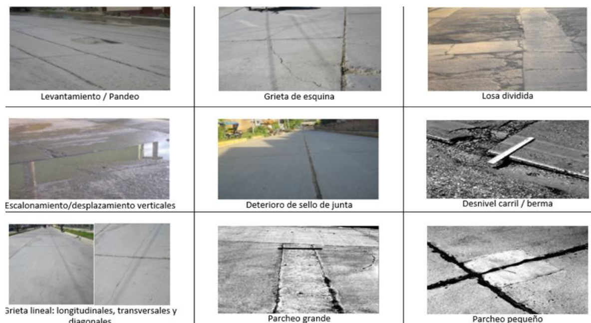
Figura 4 Fallas de pavimentos rígidos Fuente de internet
