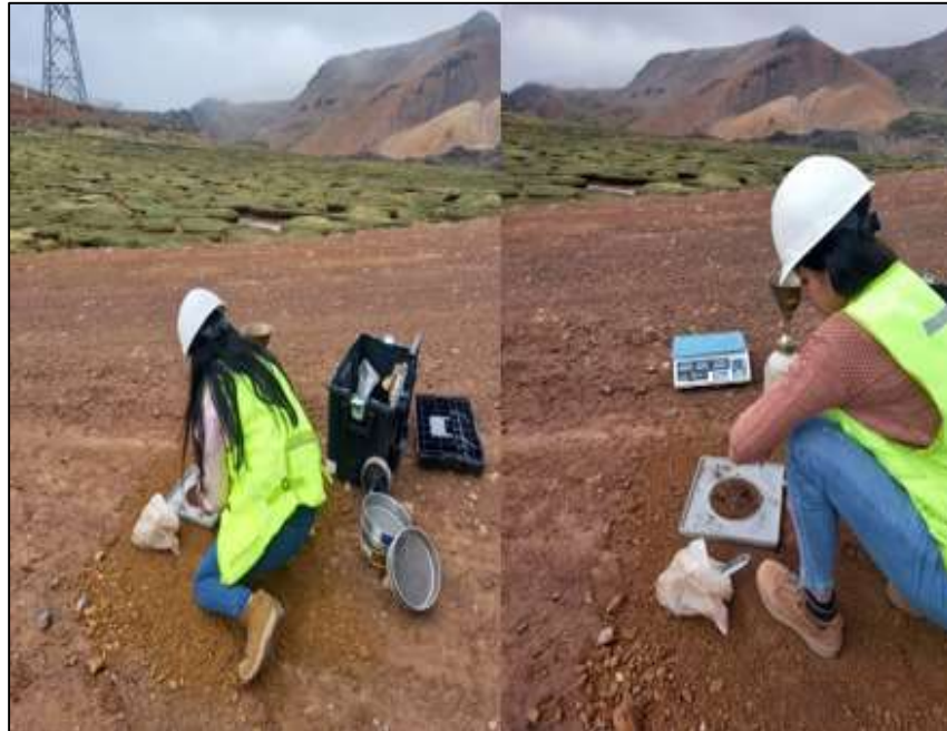
FOTOGRAFIA 57: Realización del ensayo de densidad de campo in situ de la progresiva 131+000
