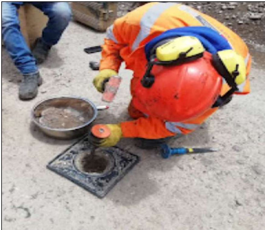
FOTOGRAFIA 64: Excavación del suelo en la progresiva 132+750
