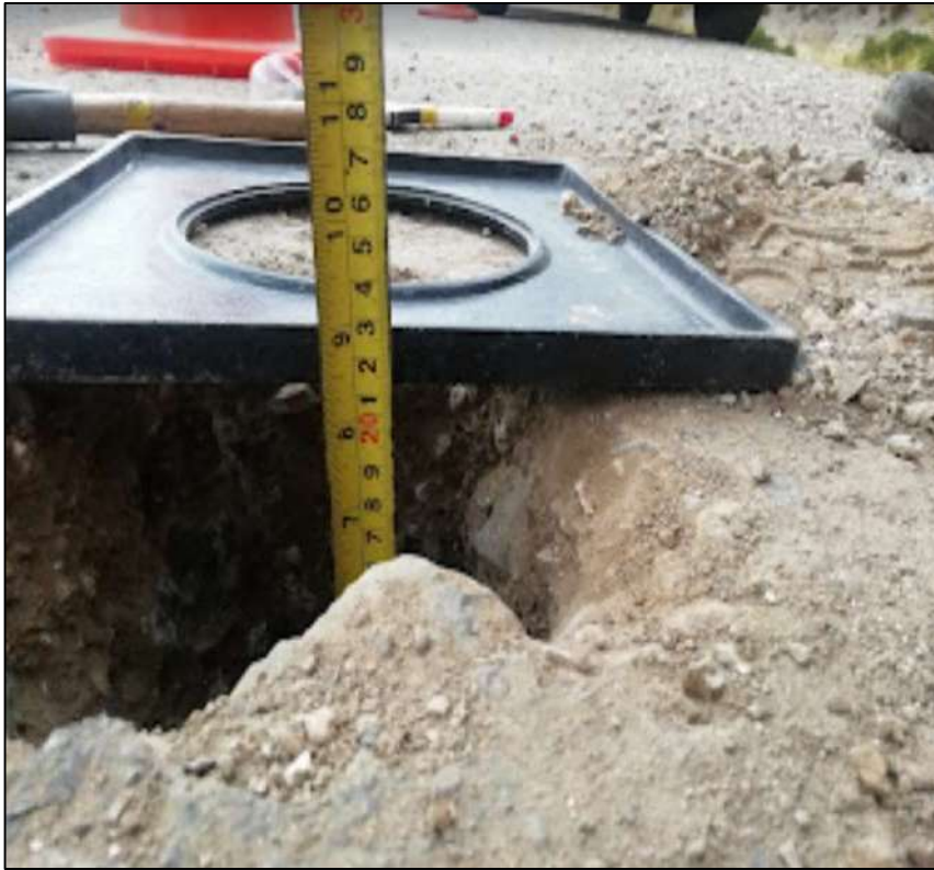
FOTOGRAFIA 67: Medición del orificio excavado en la progresiva 133+500
