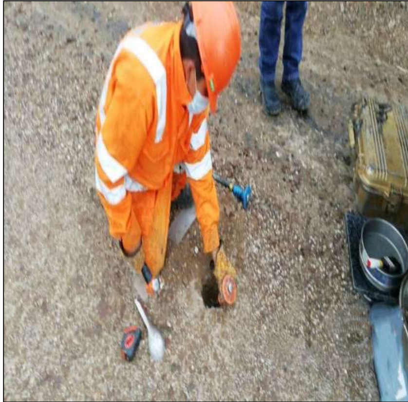
FOTOGRAFIA 59: Excavación del suelo en la progresiva 131+500
