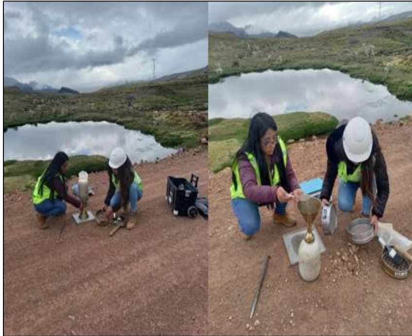
FOTOGRAFIA 61: Vaciado de la arena calibrada en la progresiva 132+000
