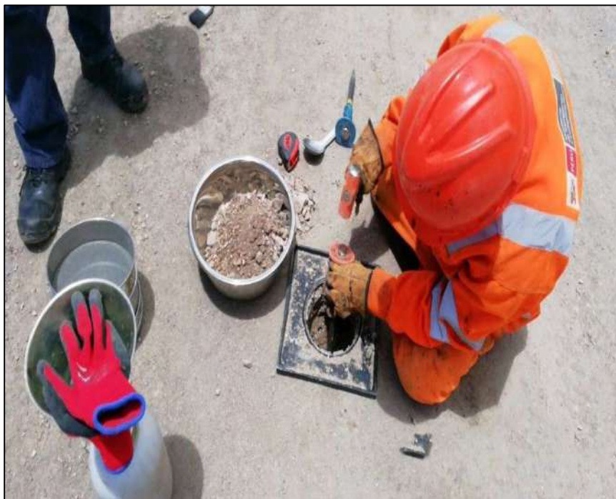
FOTOGRAFIA 56: Excavación del suelo en la progresiva 130+750
