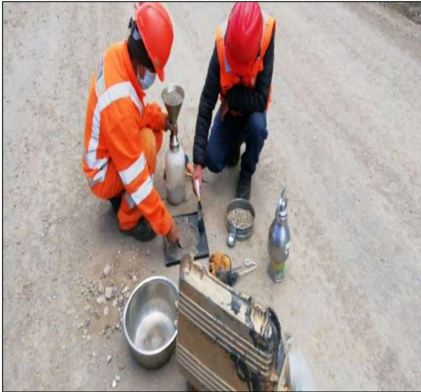
FOTOGRAFIA 55: Extracción de la muestra en la progresiva 130+500
