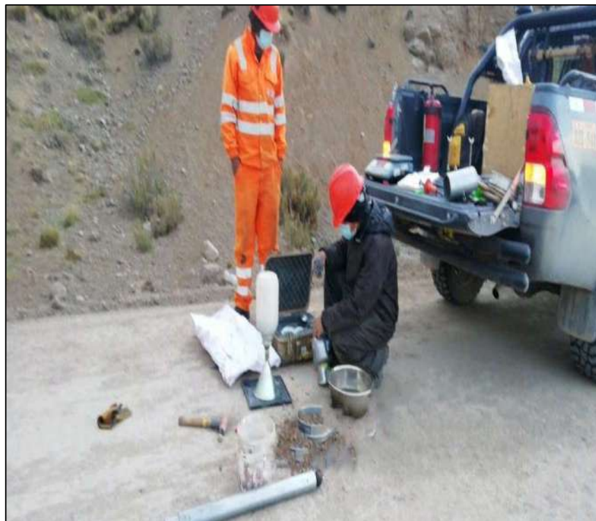
FOTOGRAFIA 62: Determinación de la humedad con el equipo de Speedy en la progresiva
