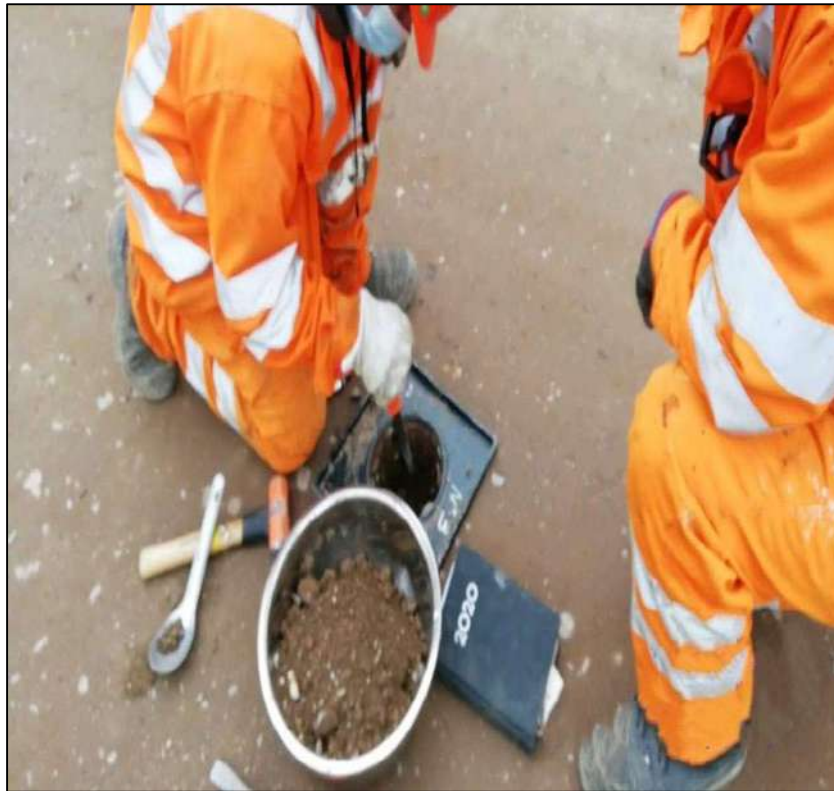
FOTOGRAFIA 53: Excavación del suelo en la progresiva 130+000
