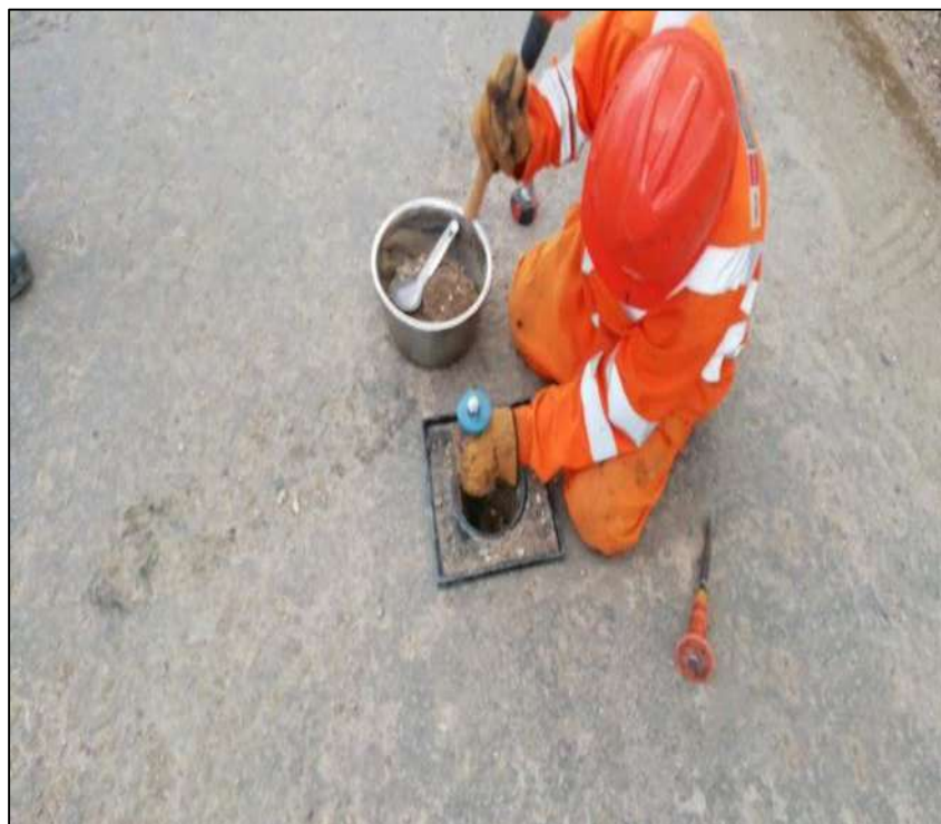
FOTOGRAFIA 58: Excavación del suelo en la progresiva 131+250
