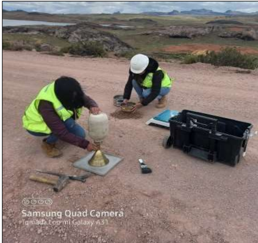
FOTOGRAFIA 51: Vaciado de la arena calibrada en la progresiva 129+000
