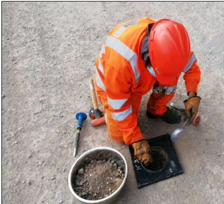
FOTOGRAFIA 66: Extracción del suelo en la progresiva 133+250
