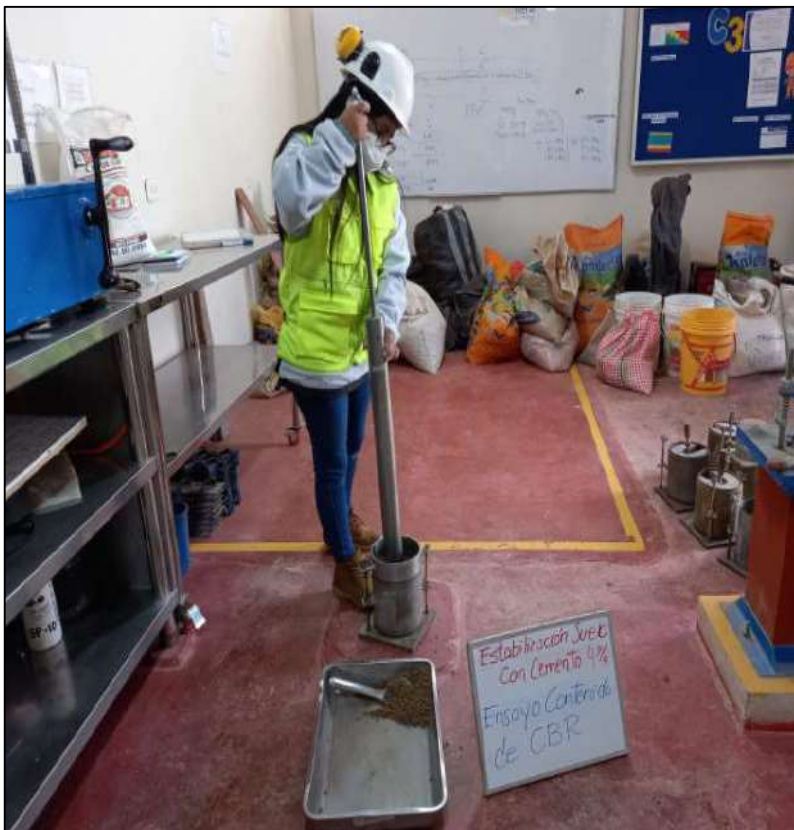
FOTOGRAFIA 30: Compactación con un buen uso del pisón.
