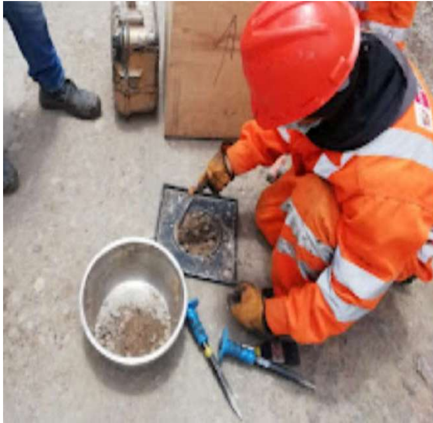
FOTOGRAFIA 65: Excavación del suelo en la progresiva 133+000
