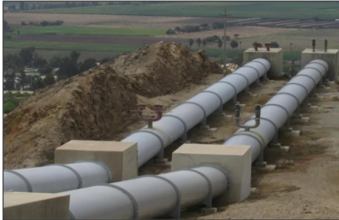
Figura N° 7. Sifón invertido
