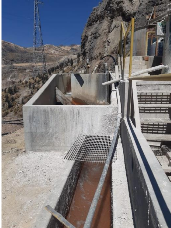
Fotografía 36. Vista de la poza de tratamiento de aguas ácidas en funcionamiento.
