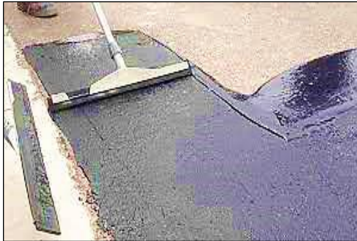
Figura 4. Asfalto utilizado como impermeabilizante.
