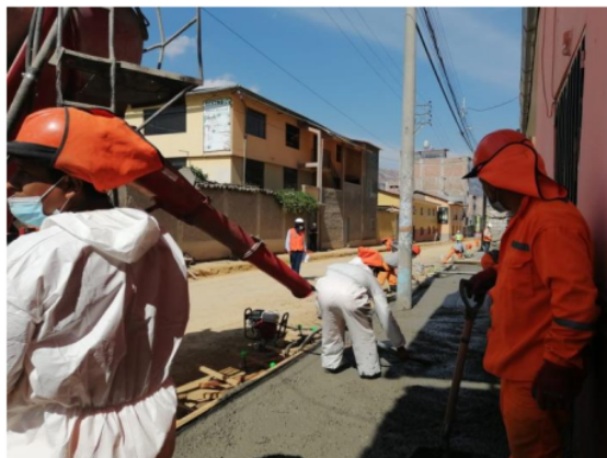
Foto 5.- Vertido de mezcla de concreto con fibra 4D
