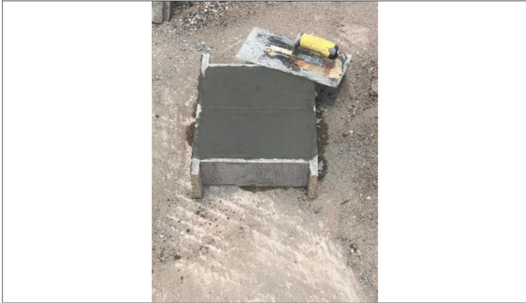
Vista 10: Semi pulido al adoquín.
