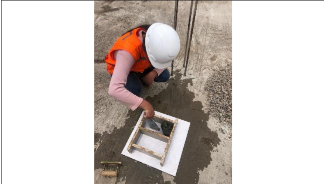
Vista 09: llenado de concreto a los moldes de adoquín.
