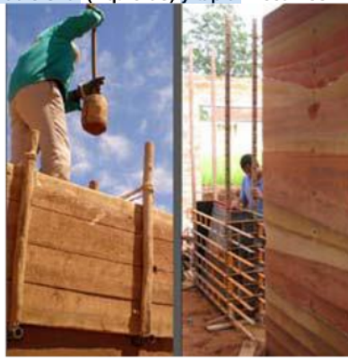
72 Grafico 23. Tipos de moldes para ejecución de tapial: tapial tradicional (izquierdo) y tapial mecanico
