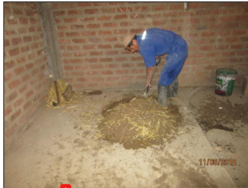
Grafico 40. Proceso de mezcla de tierra con paja
