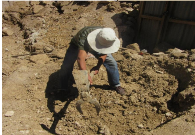
Grafico 39. Extracción de material para elaboración de adobes
