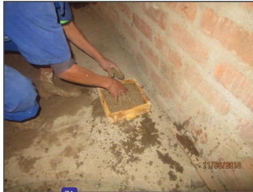
Grafico 42. Proceso de colocación de la mezcla en el molde
