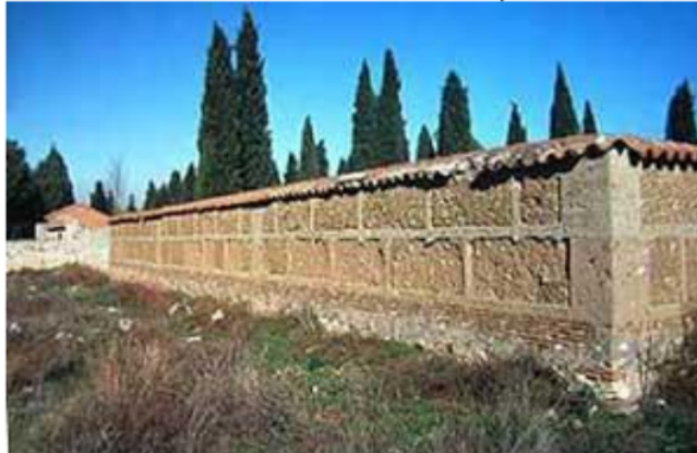
Grafico 21. Muro construido con tapial
