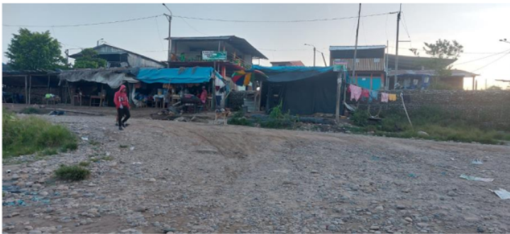
Figura 7: Vivienda de existentes de la ribera del puerto Mangualito- del segundo punto.
