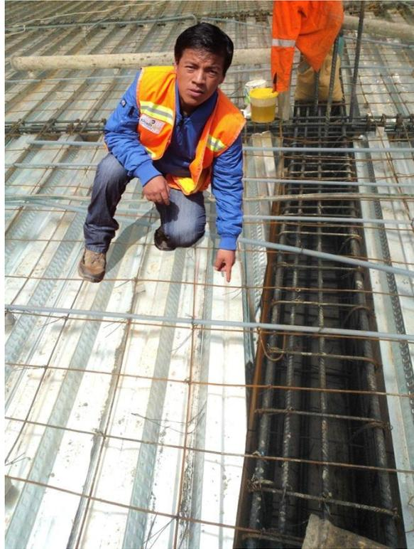
Foto N° 01: Tendido de placa colaborante y acero de temperatura.
