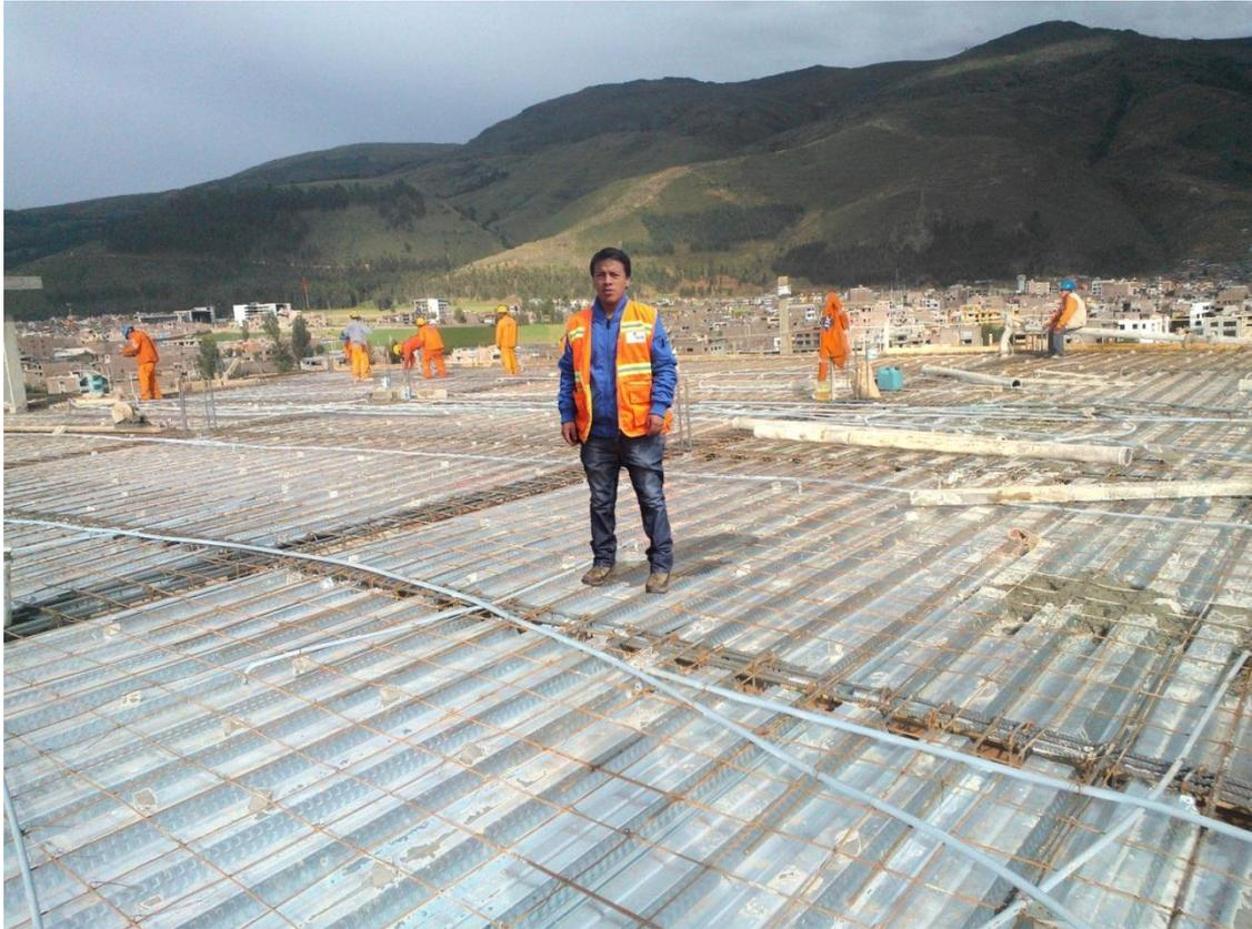
Foto N° 03: Losa de placa colaborante esperando el vaciado de concreto.
